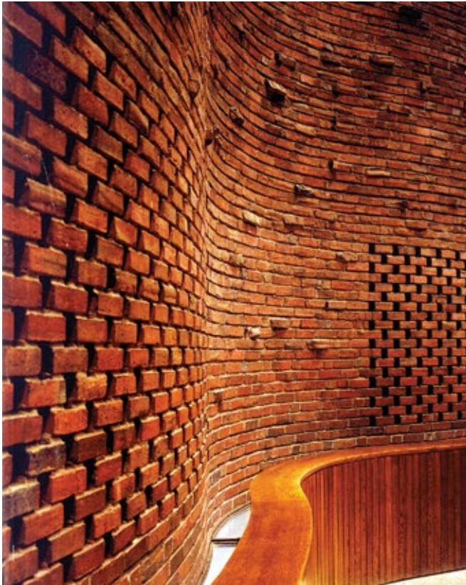
(11) Parrillas en las zonas convexas al interior.
