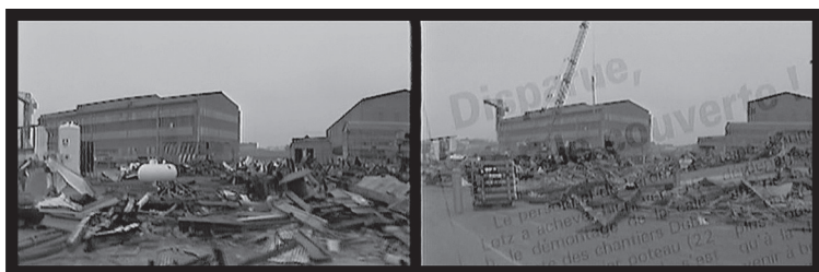
Figura 2: Demolición de las instalaciones navieras de la Prairie-au-Duc Fuente: Lebrun (2000)
