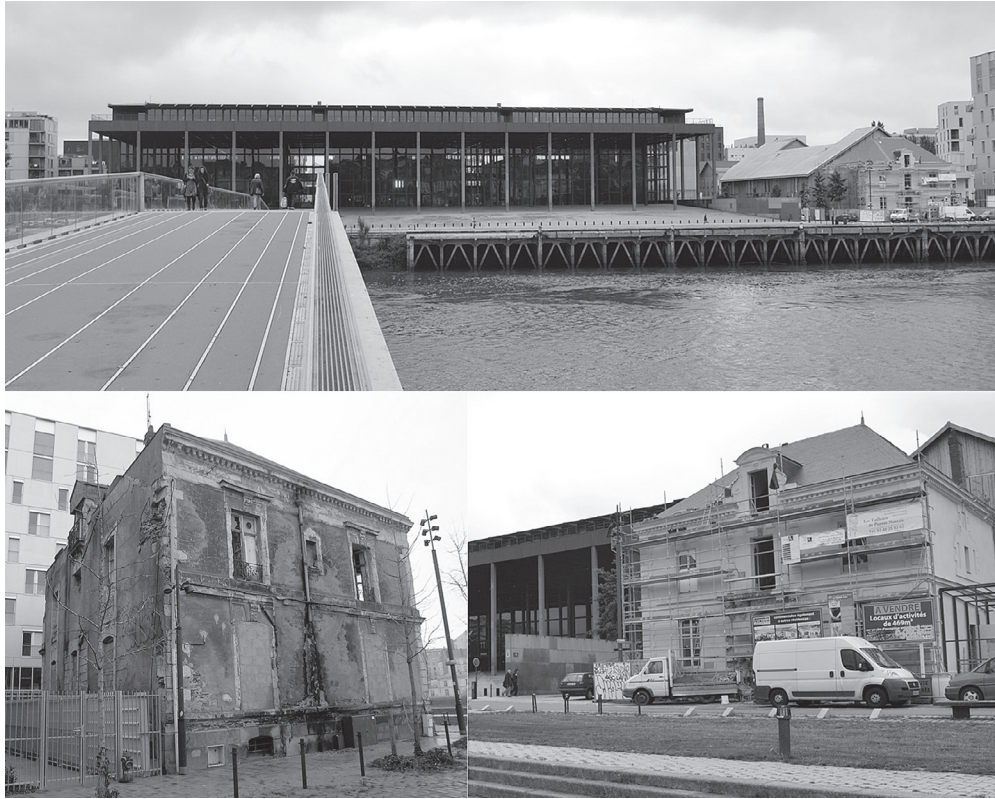
Figura 5: Palacio de Justicia y rehabilitación de edificación industrial Fuente: fotografías de la autora, 2011 y 2012
