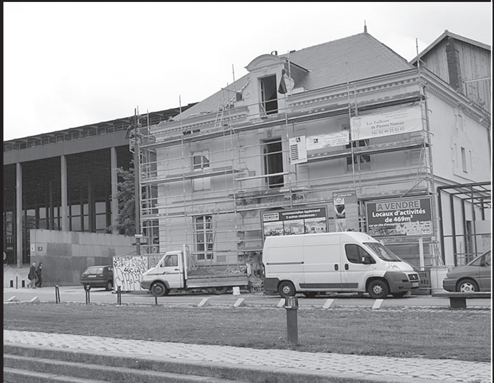
Rehabilitación de edificación industrial Fuente: fotografías de la autora, 2011 y 2012
