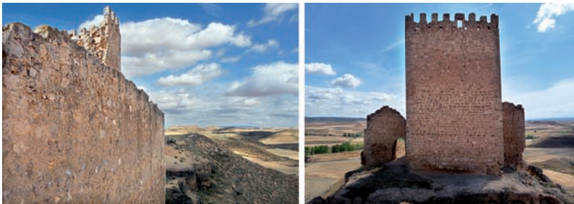
Figura 4. a. Flanqueo septentrional (fuente: IJGC). b. Vista occidental del castillo, donde se aprecia la ubicación de los mechinales bajo cada almena y el hueco practicado en un merlón para acceder al cadalso que coronaba la torre. En primer plano se observa el foso excavado que corta el terreno plano de este frente (fuente: IJGC).
