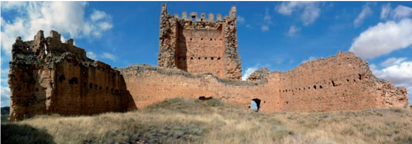
Figura 5. Vista interior del castillo y la torre, donde se aprecia el relleno de tierra del torreón suroeste (a la izquierda de la imagen) y los mechinales de apoyo de la cimbra de la bóveda de la torre (fuente: IJGC).
