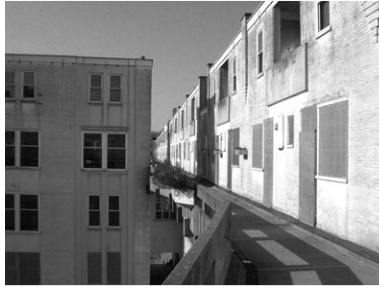
Fig. 3 Barrio Spangen. Rotterdam. 1919 - 1921 Michiel Brinkman
