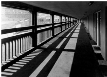
Fig. 13-14 Edificio viviendas Park Hills. Sheffield. 1961 Jack Lynn. Ivor Smith.
