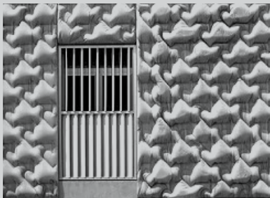
Imagen 2: M. Fisac, dos fachadas ejecutadas con encofrados flexibles.
