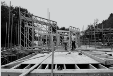
Imagen 19: Imágenes del taller (arriba y medio) y de producción (abajo) llevada a cabo en las instalaciones del Hooke Park
