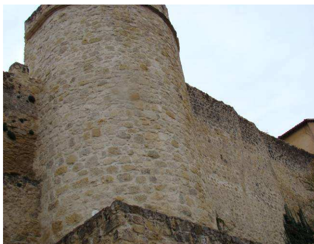
Fig. 3. Torre 59. Torre de planta circular, única excepción en la ladera norte. Se trata de una reconstrucción completa del siglo XX. Su arranque es de planta rectangular.
