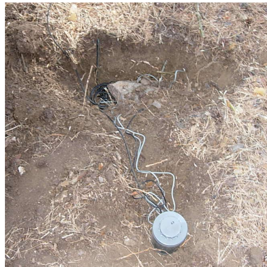
Figura II.14: Unidad Básica de Registro ya instalada, lista para ser cubierta (Foto: V. Gómez)
