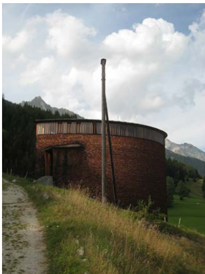
Figura 1. Peter Zumthor. Capilla Sogn Benedetg, vista exterior. Autor: Elena Pérez. 2009.
