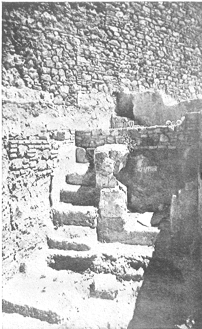
Málaga. — Alcazaba. Arranque de escalera en una de las viviendas excavadas. (Siglo XI.)
