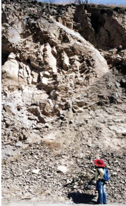
Foto 1. Desprendimiento de rocas entre Chilete y la mina Paredones.
