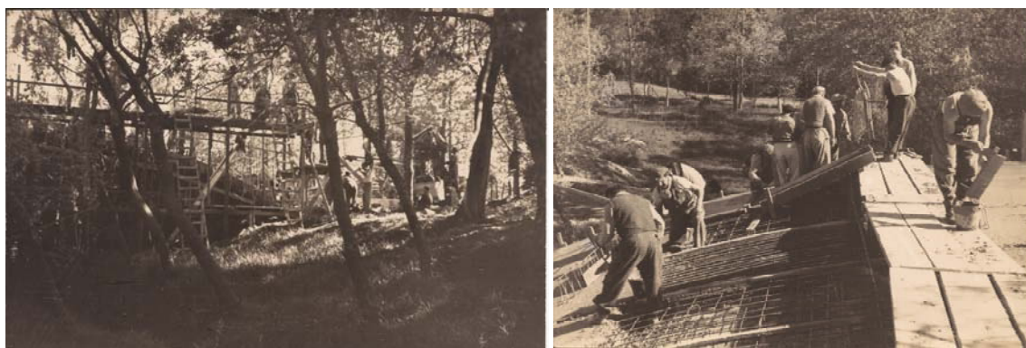
Figuras 14 y 15. Imágenes construcción de las cimbras y encofrados (Archivo Williams).
