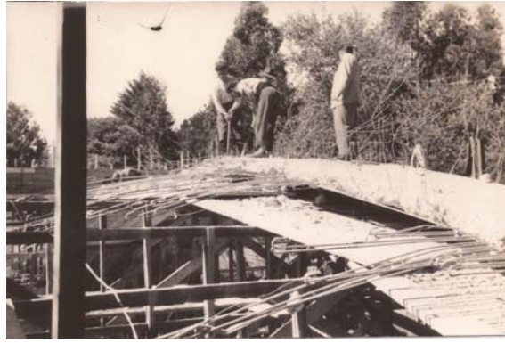
Figura 17. Fotografía con fecha 24.04.1945 del proceso de demolición de la arco de hormigón (Archivo Williams).
