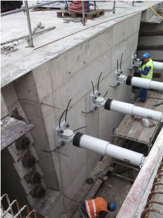
Figura 17. Colocación de los “STUs”
