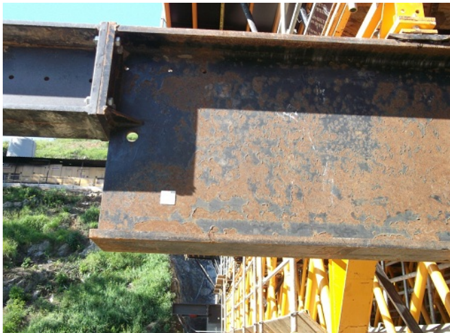
Figura 11. Colocación de dianas y registro de control topográfico
