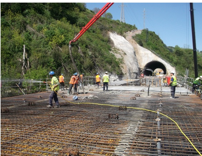
Figura 14. Determinación y colocación del armado de los “stoppers”
