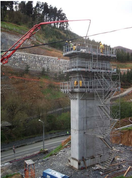
Figura 6. Construcción de una pila del Viaducto de Salubita
