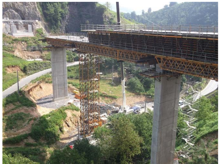
Figura 7. Disposición de cimbra en el Viaducto de Salubita
