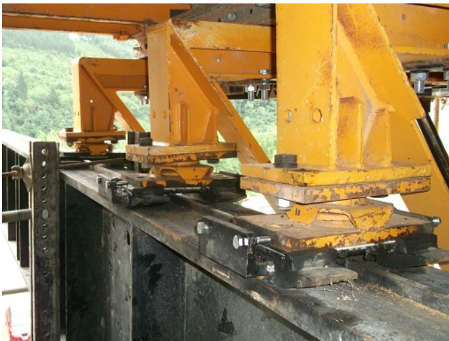
Figura 10. Ubicación de las planchas de teflón para liberación de movimientos
