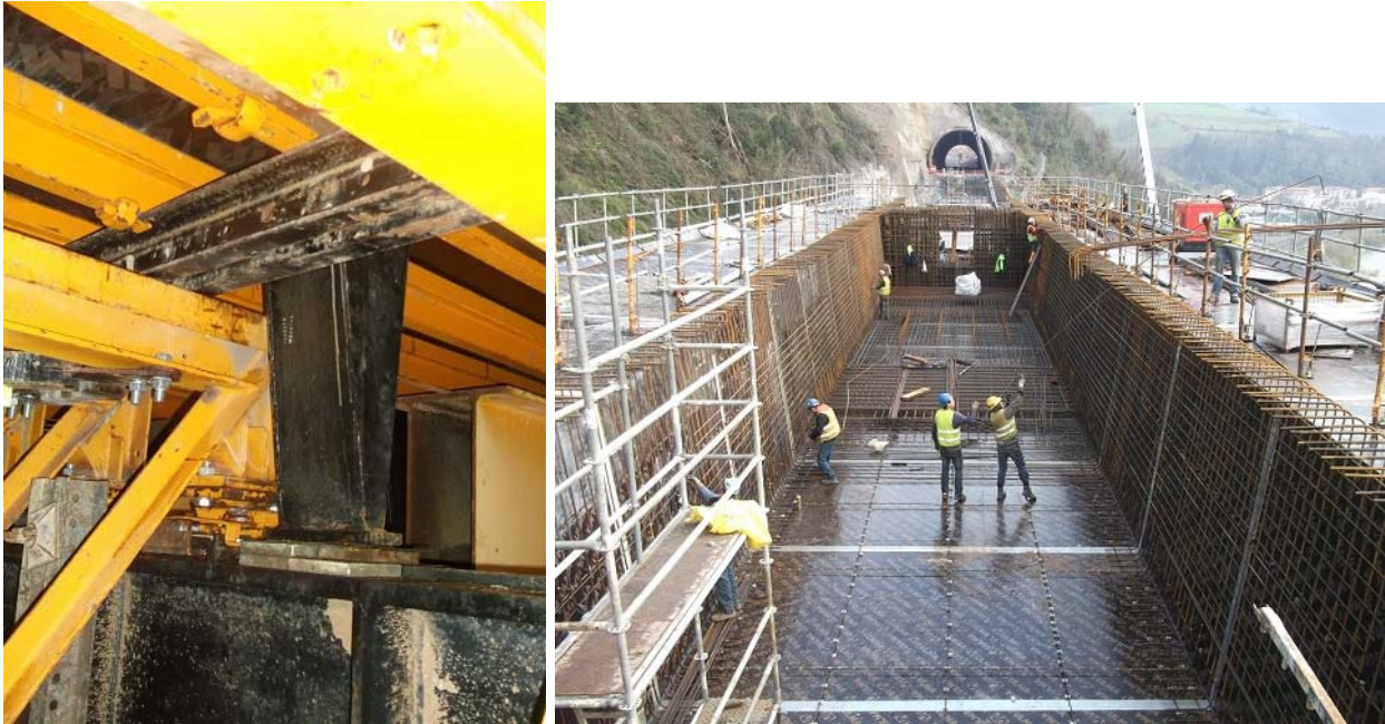
Figura 13. Disposición de “lápices” y colocación de refuerzo por ubicación de los mismos
