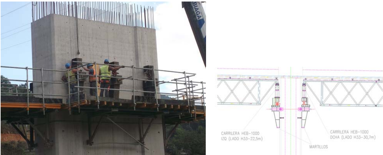
Figura 15. Configuración y colocación de los “martillos”
