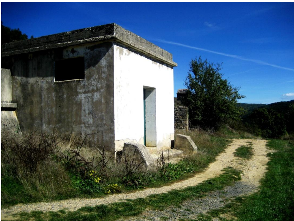
Fotografía 6: Camino que divide la vía en dos tramos y donde se localizan los depósitos de agua. (Fuente: elaboración propia).
