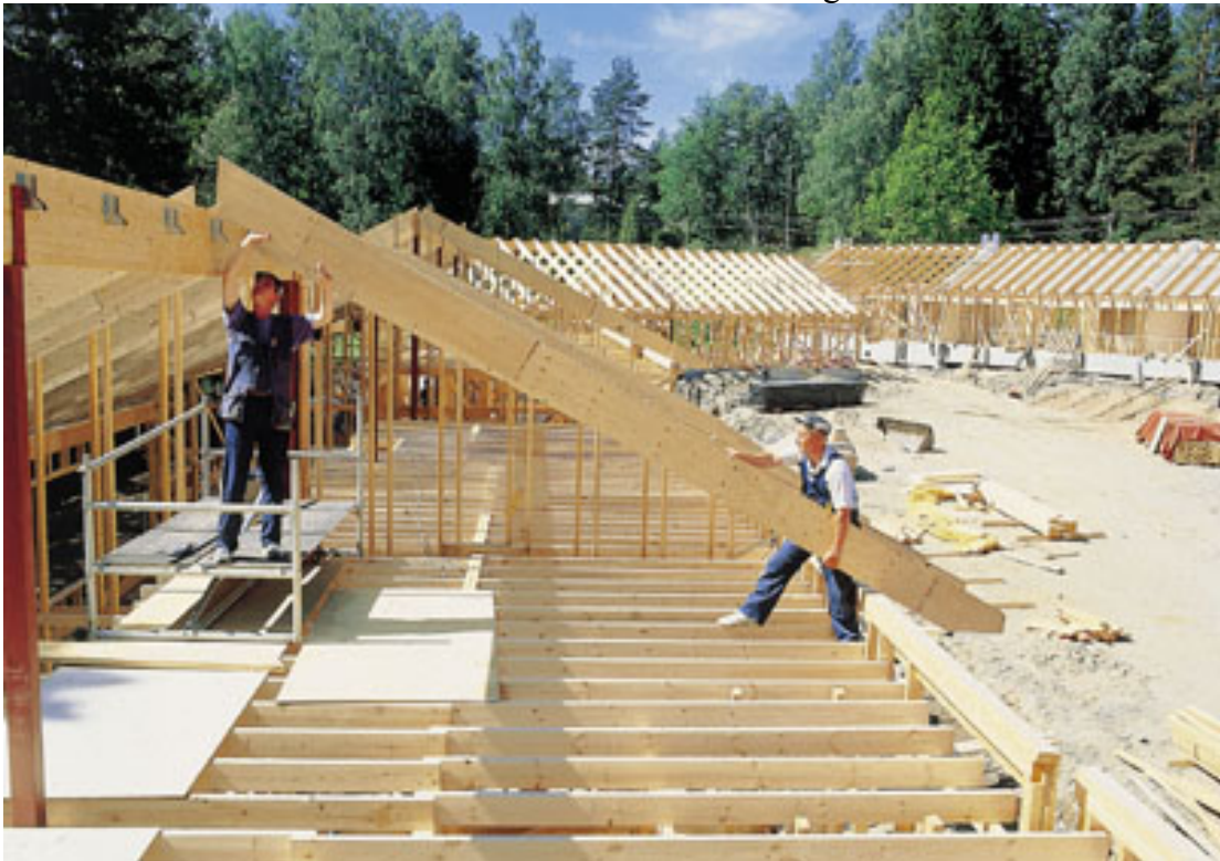
Foto 4: Cubierta de madera mediante vigas LVL
