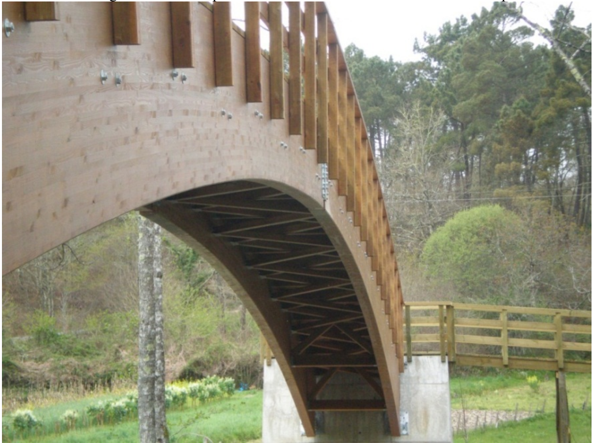
Foto 3: Viga laminada con perfil curvo utilizada en la construcción de una pasarela.
