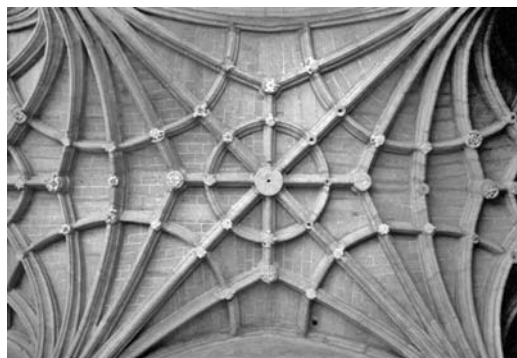
Figura 9 Crucería de las bóvedas del claustro del monasterio de san Esteban, Salamanca, obra de Juan de Álava
