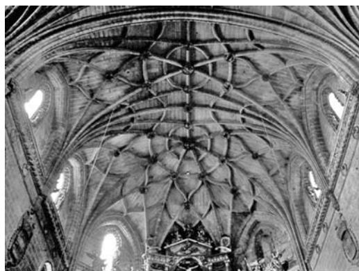
Figura 5 Bóvedas del ábside y presbiterio de la catedral de Plasencia, obra de Juan de Álava
