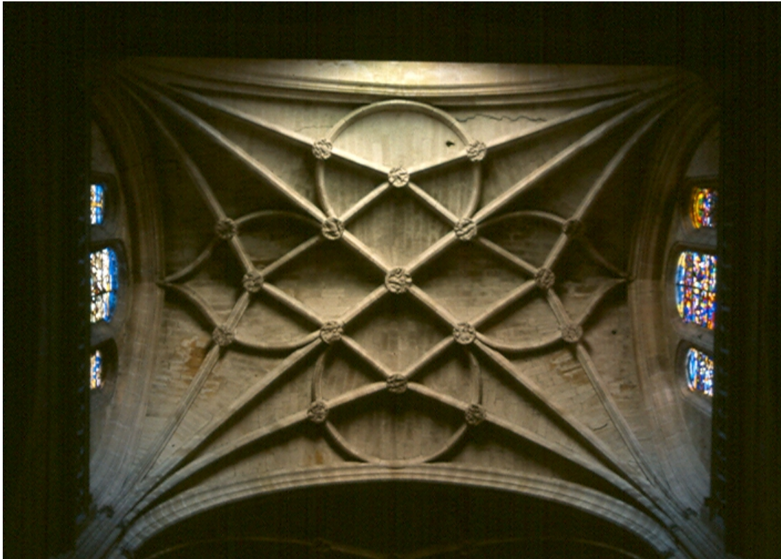
Fig. 9A Bóveda de uno de los tramos de la nave central de la catedral de Segovia. Obra de Rodrigo Gil
