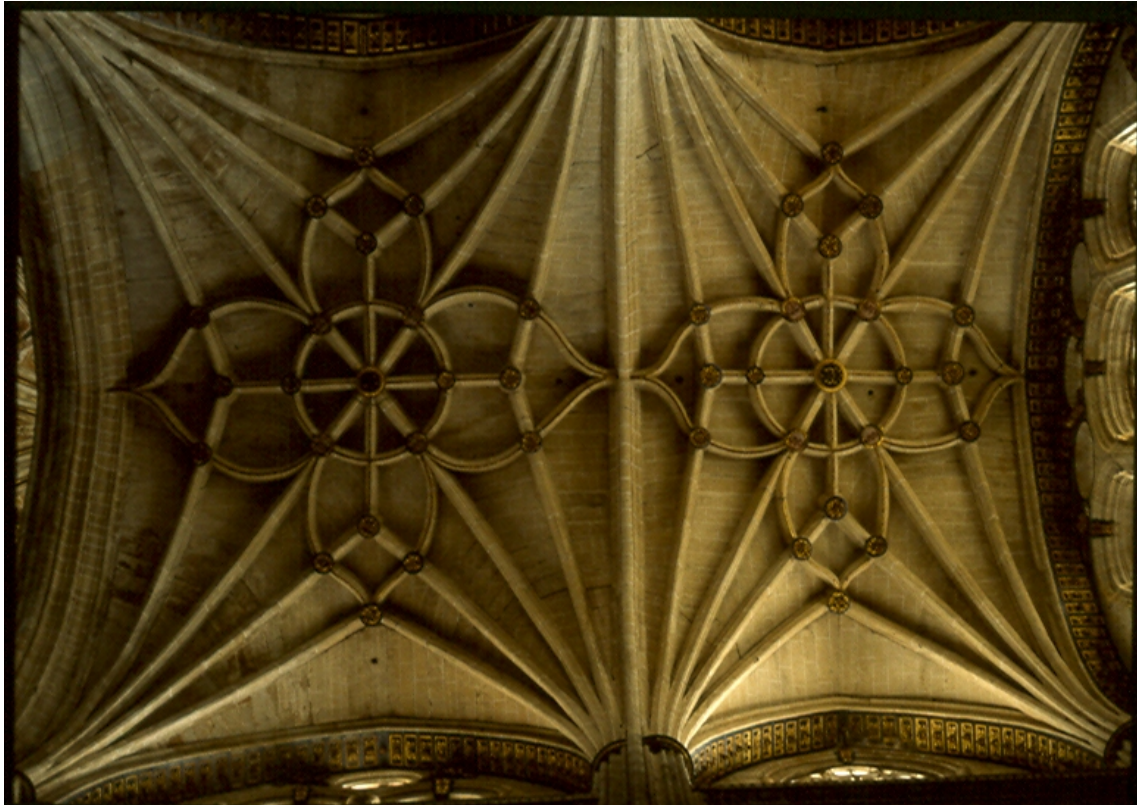
Fig. 5A Bóvedas de la nave central de la catedral de Salamanca construidas por Rodrigo Gil
