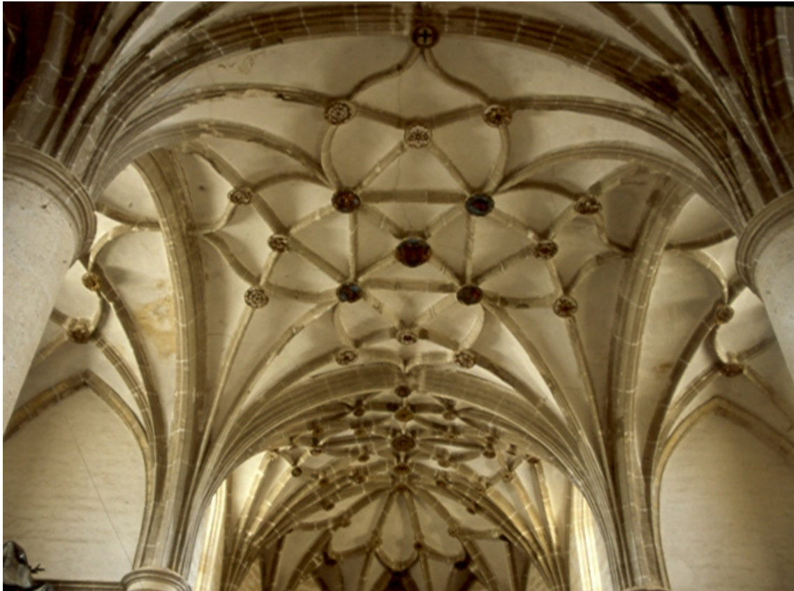
Fig. 15A Bóveda de la iglesia de san Martín, Valladolid. Obra atribuida a Rodrigo Gil
