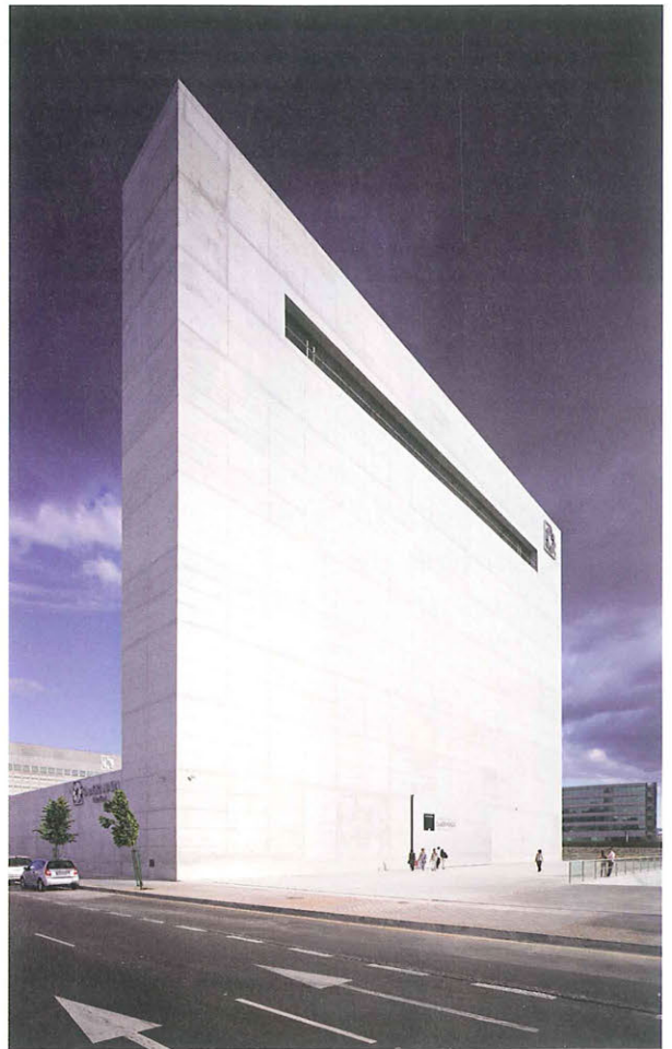
El edificio pantalla se eleva unos 49 metros sobre el suelo
