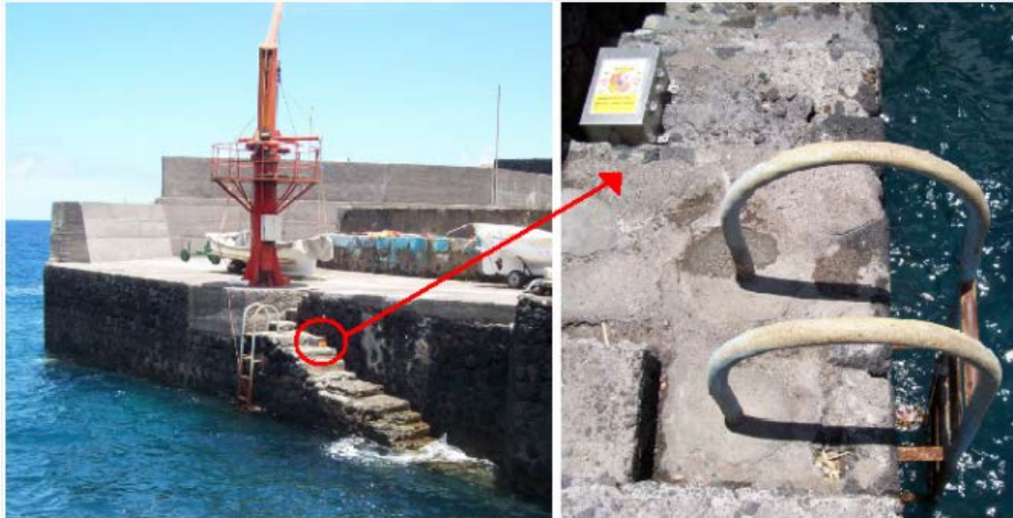
Ilustración 5: Situación y colocación de mareógrafo.
