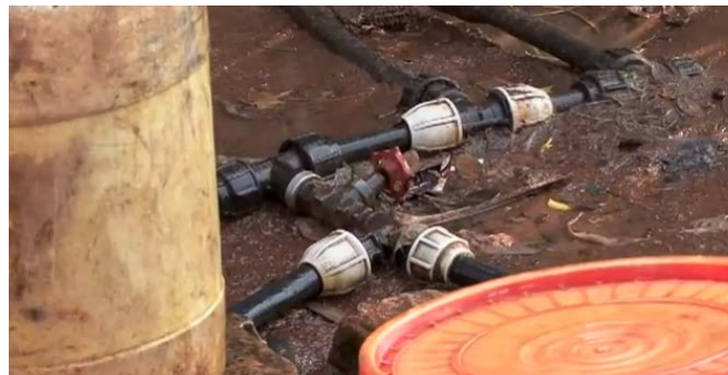
Figura 12. Instalación de agua en punto de agua. Tanzania. Fuente Ecolution-a (2011)
