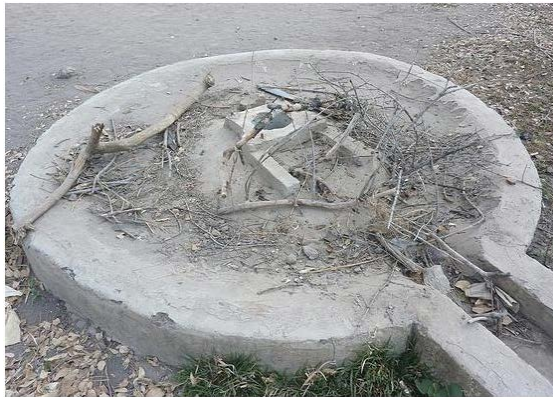
Figura 1. Punto de agua abandonado. Tanzania. Fuente MSABI [7]
