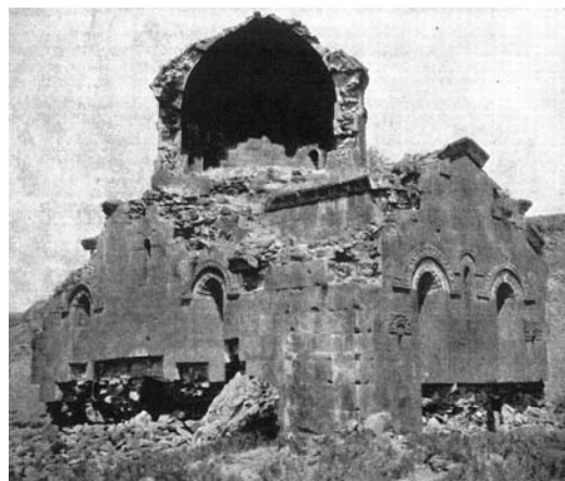
Figura 2 Iglesia del convento de Horomos en Ani. Las placas de piedra sirvieron de cimbra para la construcción de la cúpula de hormigón (Strzygowski 1918; foto Toramanian)
