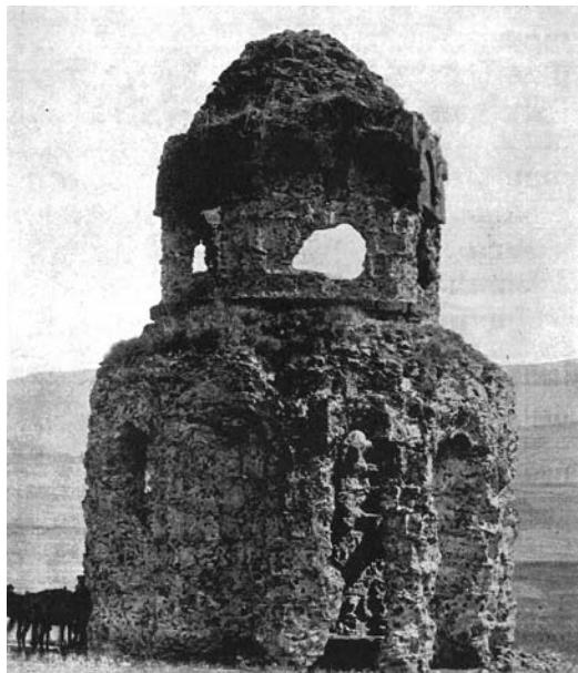
Figura 1 Construcción armenia de hormigón (iglesia en Goguba). Las placas de piedra del revestimiento han sido robadas, salvo en la parte superior (Strzygowski 1918; foto Jermakov)
