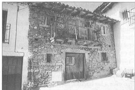
Vivienda en la calle Real, 59
