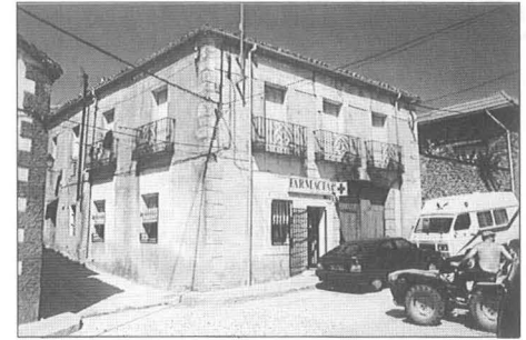
Vivienda en la calle Sánsano
