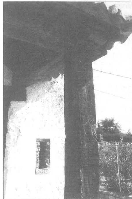
Detalles del pórtico y ventana
