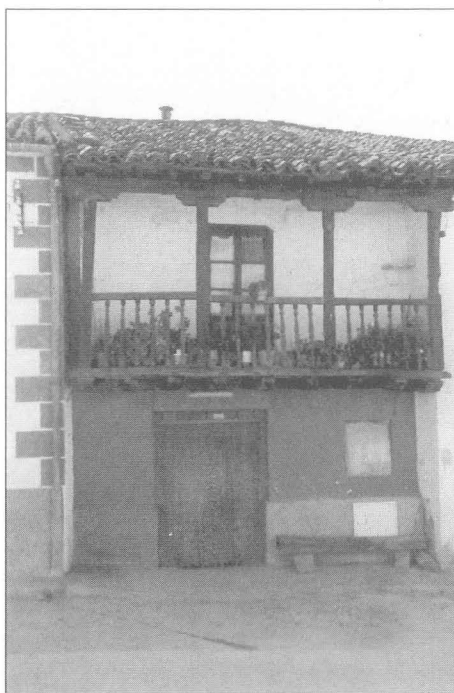
Vivienda en la Puerta del Sol, 9
