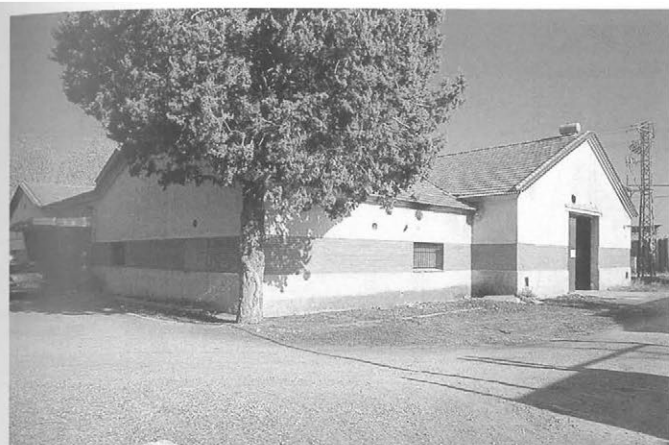
Granja avícola del Jarama, nave principal.
