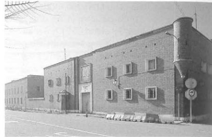
Casa cuartel de la Guardia Civil en Puente de Arganda.
