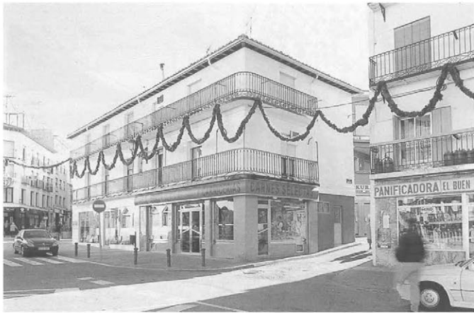
Vivienda en plaza de la Constitución c/v calle Juan XXIII c/v calle Tiendas.
