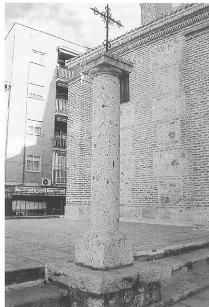
Columna perteneciente a la desaparecida arquería del patio principal.
