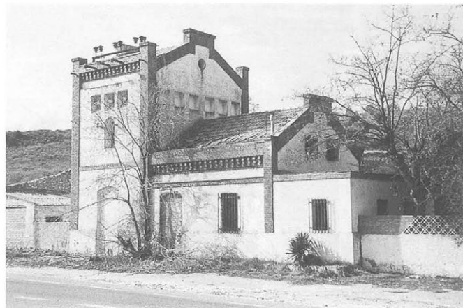
Caseta transformadora de Valderribas. Foto Virginia Torres.
