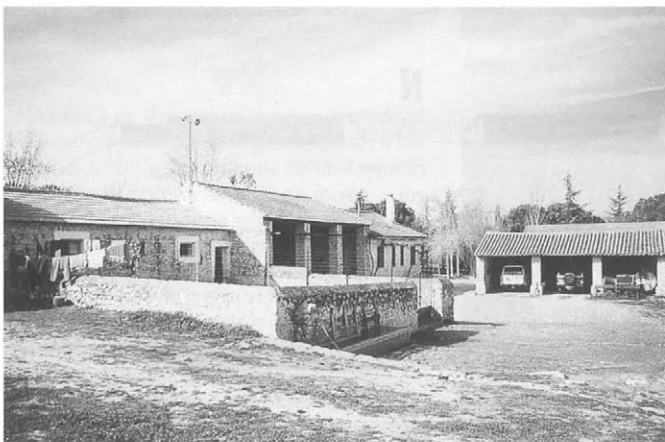
Finca residencial agropecuaria. Construcciones anejas. Foto Virginia Torres.
