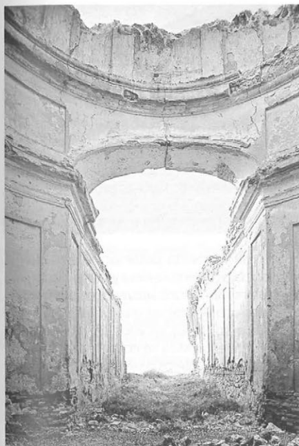
Iglesia. Restos nave desde cabecera.
