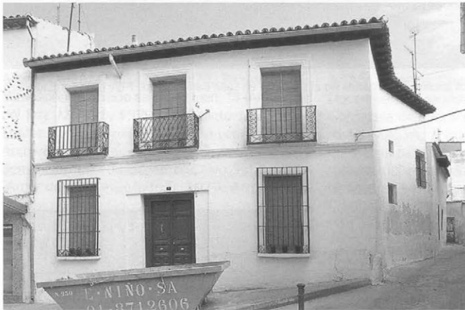
Vivienda en calle de los Silos, 7.
