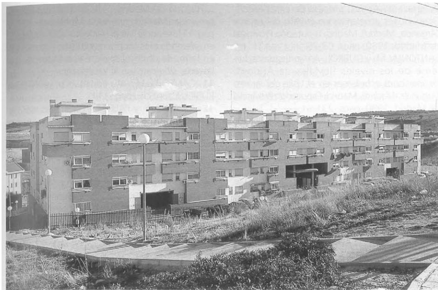
Bloque de vivienda colectiva en calle Camino del Molino.
