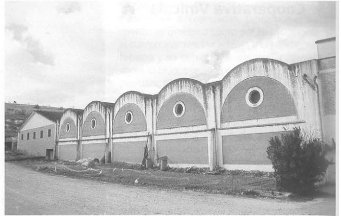
Vista de las naves.
