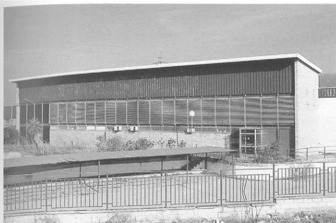
Nave en polígono industrial.
