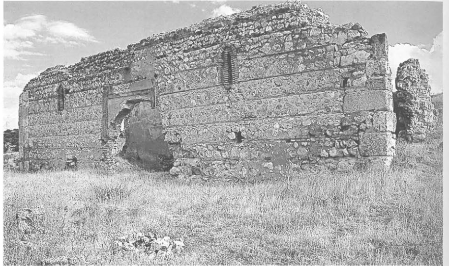
Ermita, restos fachada acceso.
