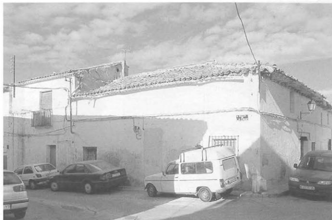
Vivienda en calle Eusebio Villalvilla, 12 c/v calle de la Cruz.
