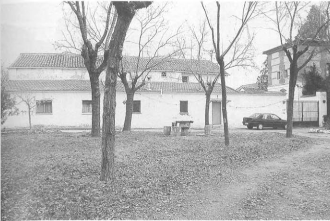
Finca residencial. Construcciones anejas.
