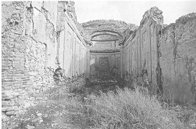
Iglesia. Restos nave y presbiterio.
