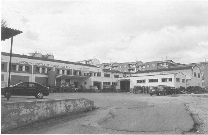
Vista del acceso.
