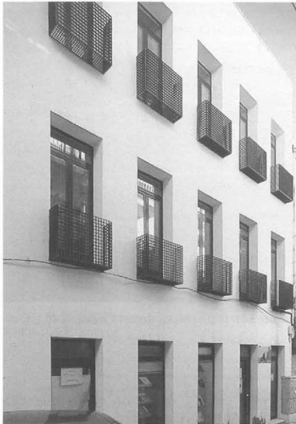
Biblioteca municipal Pablo Neruda, calle Tiendas, 6. Amp.ref. Arquitecto Alfonso Grané Lizana, 1991.
