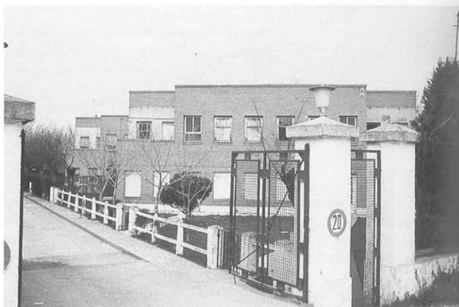
Vivienda para trabajadores del "Centro Emisor de Arganda". Foto Virginia Torres.
