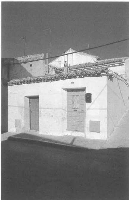
Vivienda en calle Carretas, 31-33.
