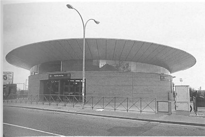
Estación de metro de Arganda, 1999.
