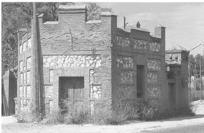
Antigua fábrica Azucarera en La Poveda, edificio de control y vigilancia del acceso.
