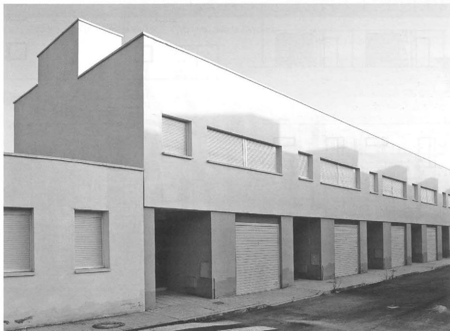
Tipología viviendas adosadas. Fachada delantera.
