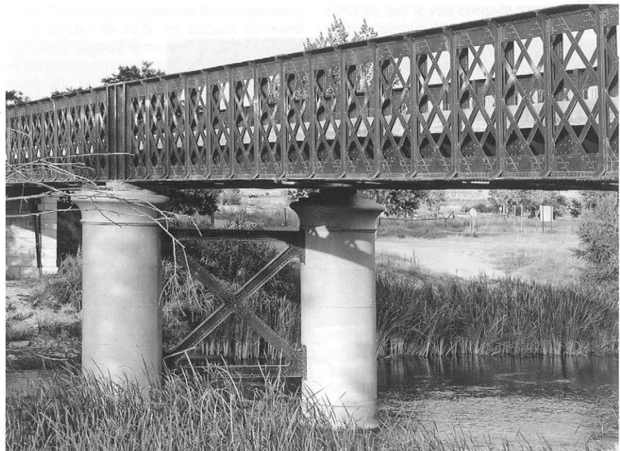
Detalle pilones centrales.
