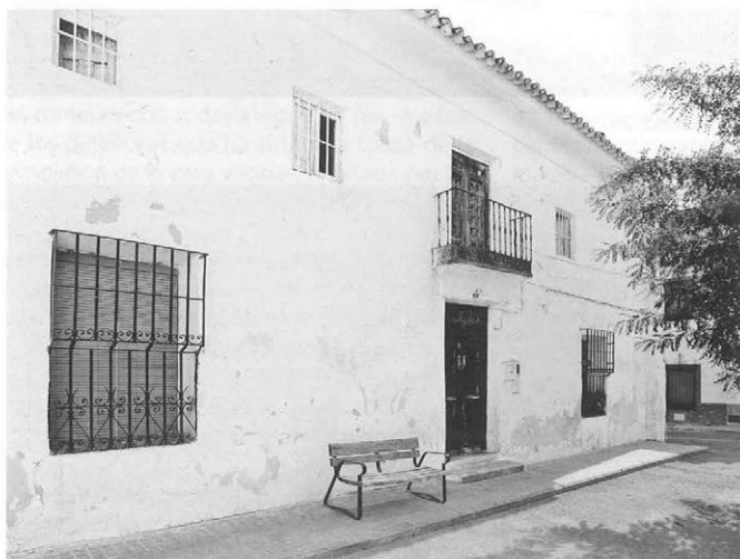
Detalle vivienda calle Mayor, 28.
