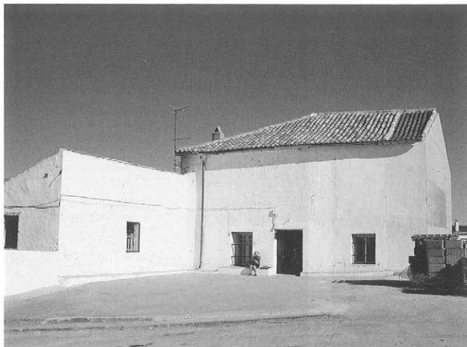
Parte de la casa de la Encomienda, en plaza de la Caserna, 1. Foto Inmaculada Sánchez.
