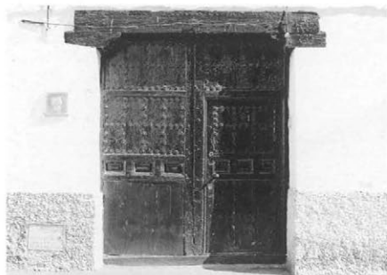
Detalle puerta en calle Comunidad de Madrid, 6.
