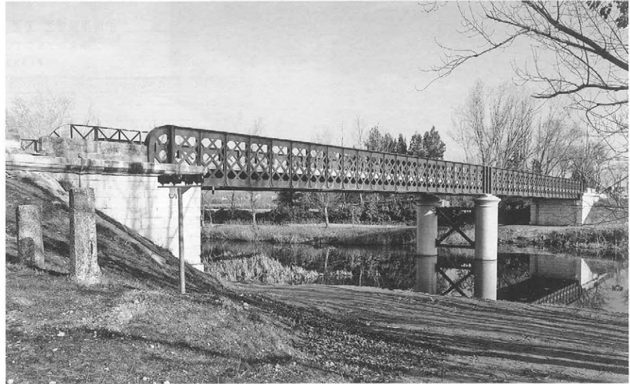
Vista del Puente de Hierro desde margen derecha.
