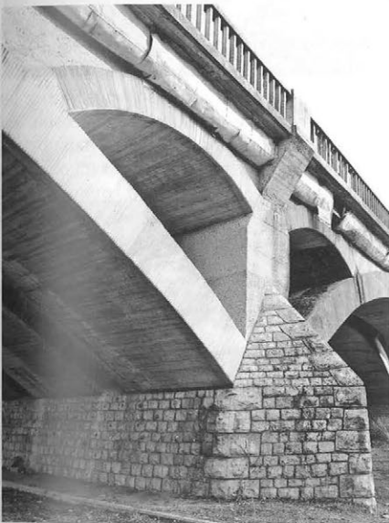
Detalle apoyo tablero en arco. Foto Inmaculada Sánchez.
