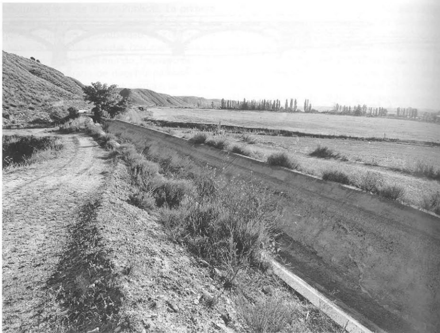
Tramo de canal paralelo a carretera de Villamanrique.
