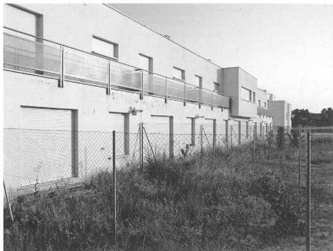
Viviendas adosadas. Fachada trasera.
