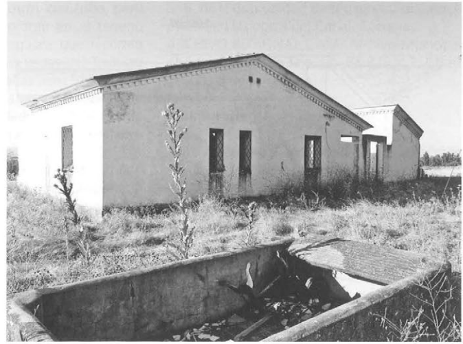
Casa mantenedores del Canal.
