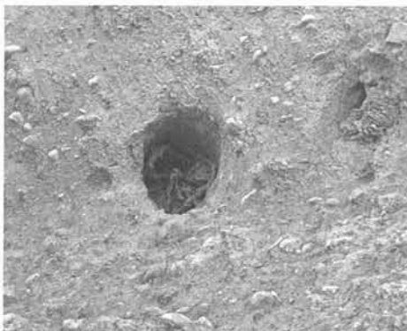
Figuras 6 y 7. Rollizos embebidos entre el muro occidental y el muro septentrional. Remate de fábrica de cal y canto encofrada en el muro occidental. Esta parte del muro se derrumbó en marzo de 2011
