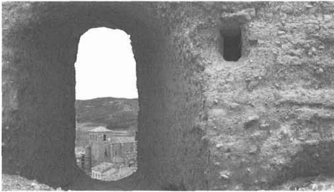
Figura 9. Hueco en el muro norte por la que se divisaba la población de Serón que se extiende a los pies del castillo y el valle del río Nágima que comunica Monteagudo de las Vicarías con Gómara
