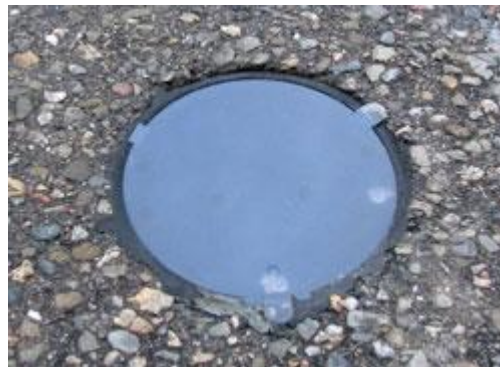
Figura 15. Sensor incrustado en el asfalto [19]
