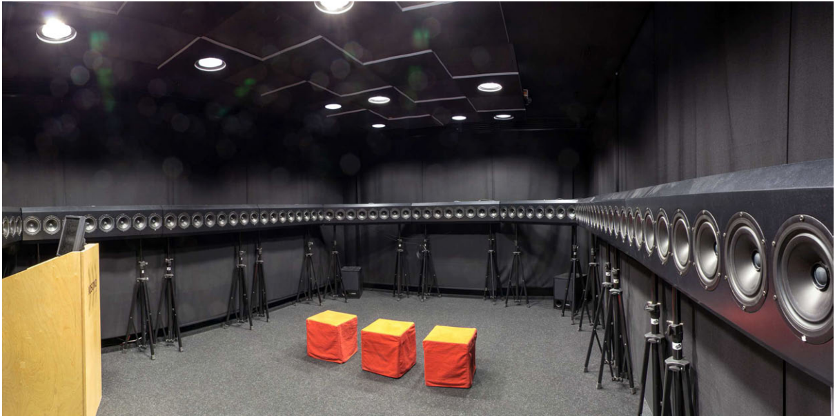
Figura 2.6. Sala de escucha compatible con el Método de Reconstrucción de Frente de Onda
