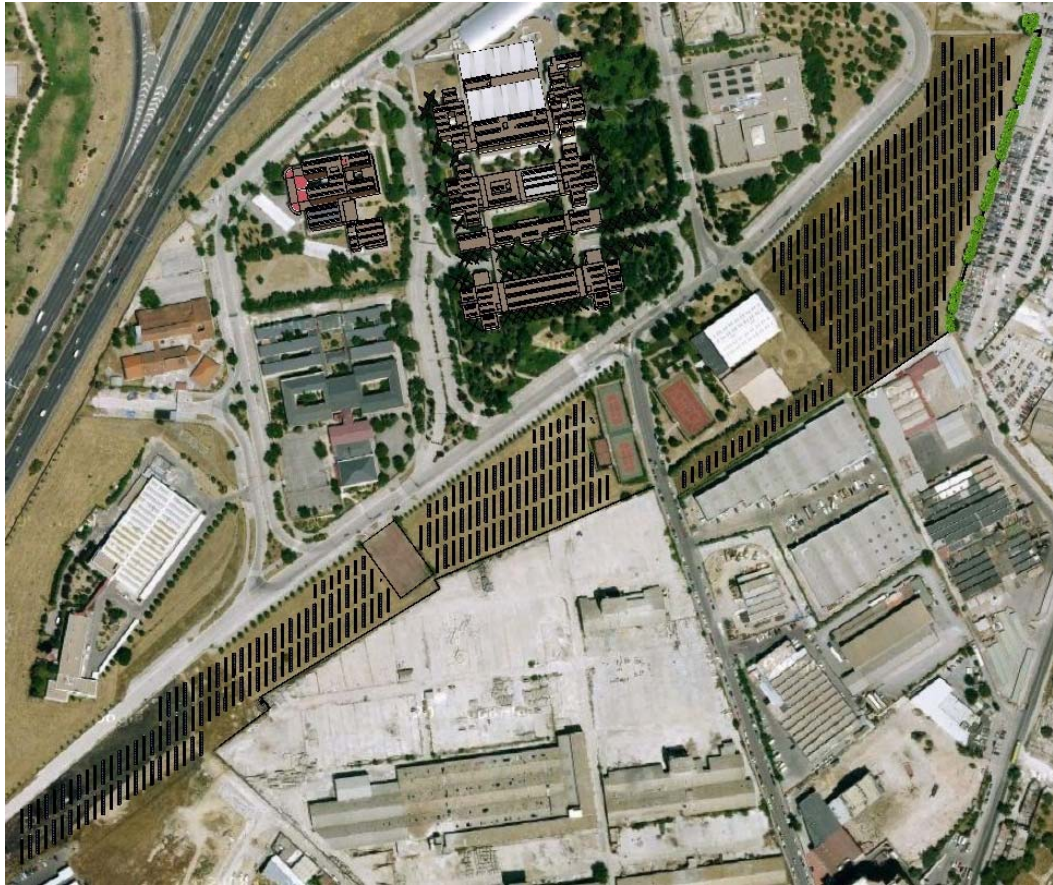
Ilustración 19. Distribución de los generadores fotovoltaicos en el Campus Sur.
