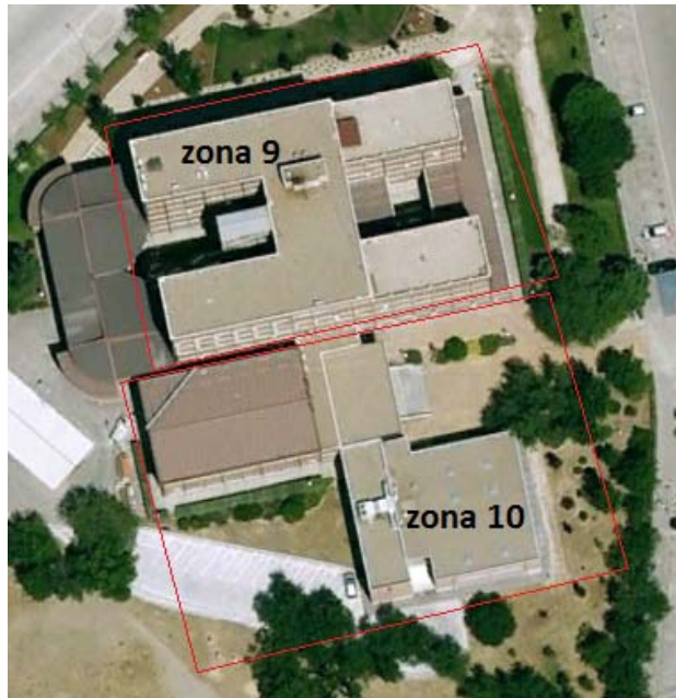
Ilustración 25. Numeración de las zonas correspondientes a las azoteas de ETSI Topografía utilizadas en la instalación.
