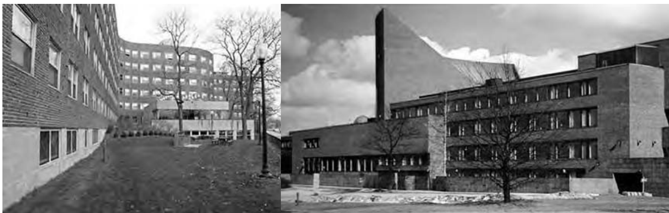
Fig. 6. Ritmo de huecos que imprime una marcada horizontalidad. Izquierda: Baker Dormitory . Derecha: Universidad Politécnica de Otaniemi.
