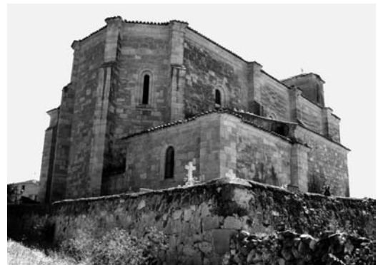
Figura 1 Vista de la cabecera y la fachada Norte
