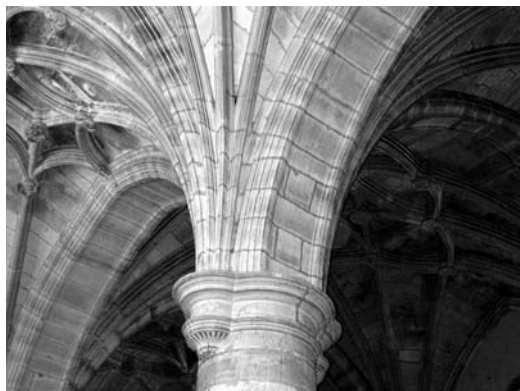
Figura 12 Detalle del arranque de las bóvedas en el pilar, con los arranques de las bóvedas a nivel
