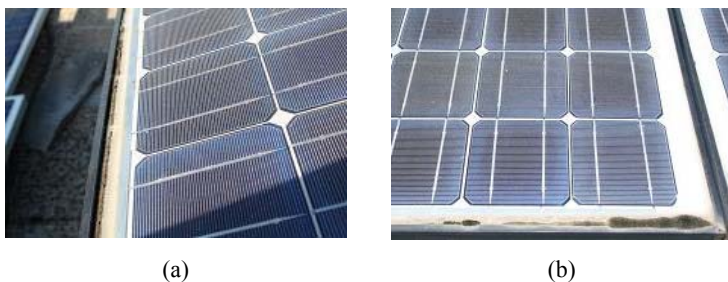
Figura 3. Defectos visuales aparecidos en los módulos tras 16 años de funcionamiento: (a) roturas y (b) musgo en la unión entre el marco metálico y el laminado.
