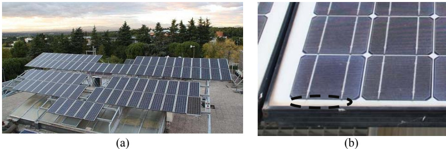
Figura 1. (a) Vista general de la instalación. (b) Vista en detalle de uno de los módulos. La separación de 2 cm entre el marco y las células en la parte inferior del mismo ha evitado que la suciedad afecte al rendimiento energético y a la seguridad eléctrica.
