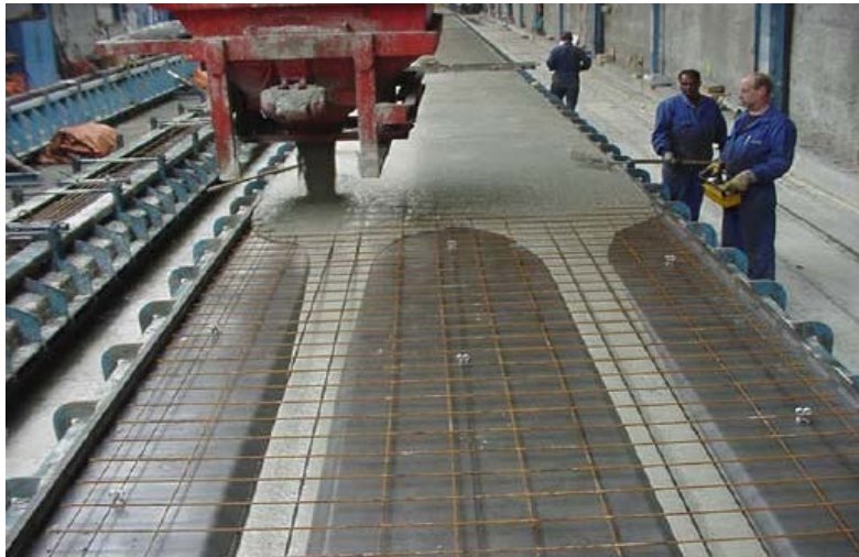
Figura. 2.- Vertido de hormigón autocompactante en elementos prefabricados (EFNARC, 2006).
