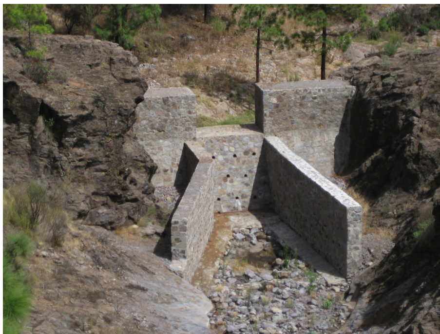
Figura 7; hidrotecnia o elemento de corrección de cauce en un barranco volcánico, esta tipología de obras en el ámbito de la ingeniería forestal, se hace muy necesaria en las islas volcánicas debido al régimen torrencial de sus precipitaciones y el elevado caudal de sólidos que pueden llegar a transportar, afectando a infraestructuras o poblaciones aguas abajo.
