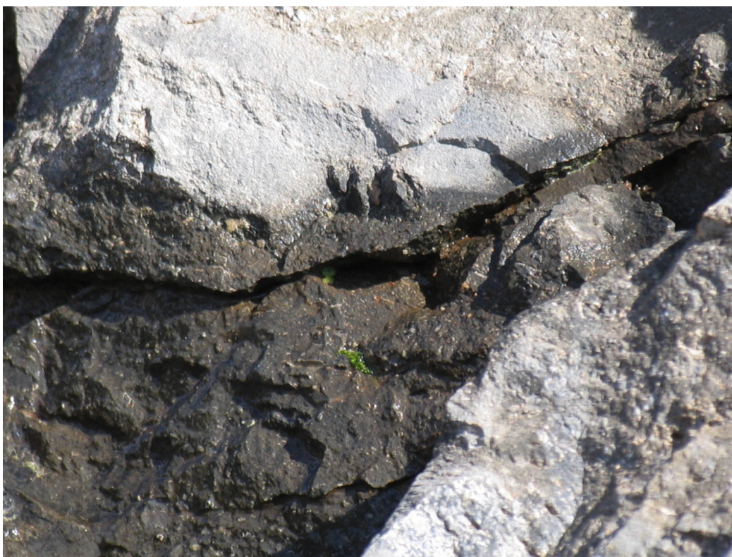
Figura 1; Fisura con agua en basalto compacto, el agua transcurre por gravedad de cotas elevadas hacia las de menor altitud, en ese camino discurre por diversos materiales, unos impermeables como los paleosuelos, diques ... y otros más permeables como las escorias de las coladas, las fisuras . El buzamiento de las coladas es muy importante también a la hora de condicionar los movimientos del agua en un terreno volcánico.
