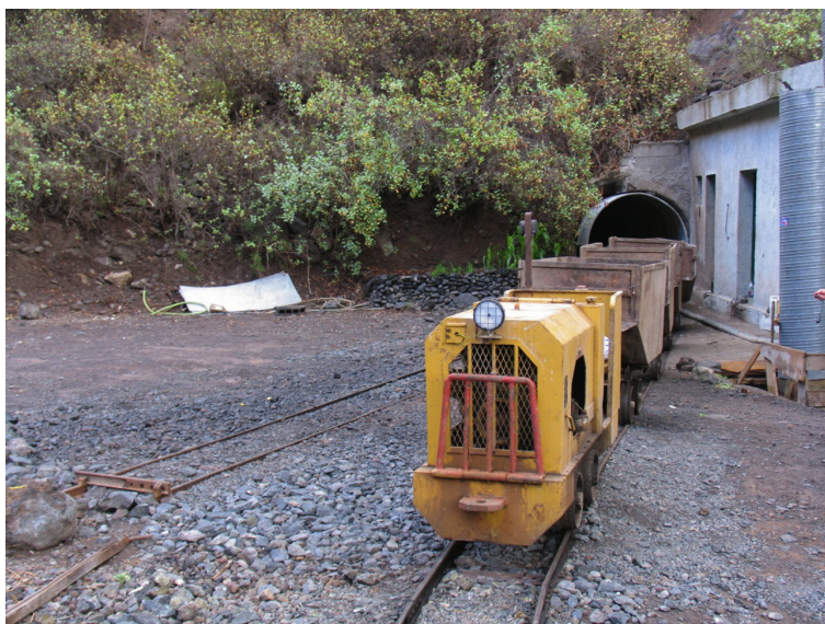
Figura 4 ; bocamina de una galería de agua y tren de transporte de operarios y material, a la derecha almacén de material e instalaciones auxiliares, también se puede observar los sistemas de ventilación. En algunas ocasiones los trabajos comienzan de madrugada , para evitar la mayoría de los gases que se forman en los frentes de mina , otro problema en la perforación de esta tipología de minas son las altas temperaturas de trabajo, en algunas ocasiones cercanas a 50°.
