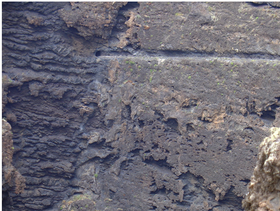
Figura 9 ; canal excavado en roca en la isla de Tenerife ( Los Gigantes-Masca) , nótese la dificultad de la ejecución de la obra de transporte , sobre todo a la hora de mantener una pendiente constante.
