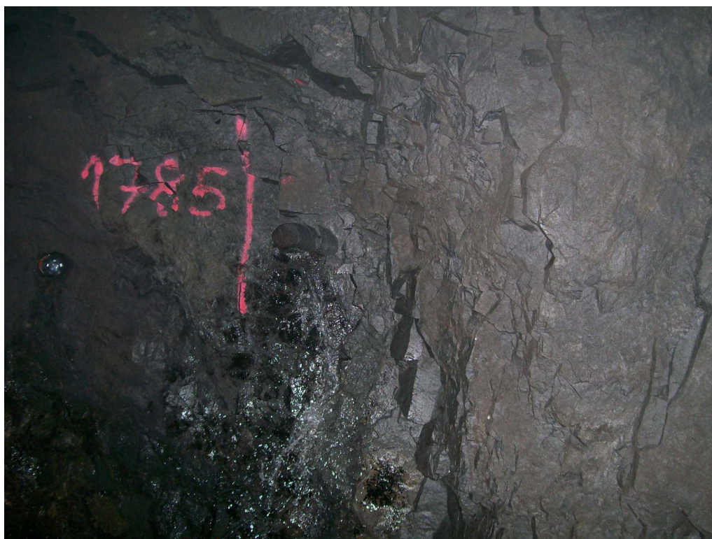
Figura 3 ; fisura con aporte de agua dentro de una mina de agua en la isla de La Gomera , se observa que la longitud a la que nos encontramos dentro de la explotación es 1.785 metros, es necesario perforar con mucha precaución y con un sondeo horizontal de al menos 50 metros para detectar bolsas de agua tras los diques.
