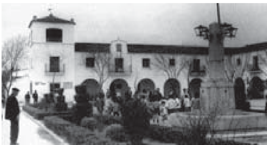
9.12. La plaza como escena urbana representativa, evocando una imagen icónica de lo que se entiende por plaza de un pueblo: espacio de perímetro porticado y con presencia destacada del ayuntamiento y su torre municipal. Nuevo pueblo de Guadiana del Caudillo (F. Giménez de la Cruz, Badajoz, 1947); Arch. Minist. de Agricultura.
