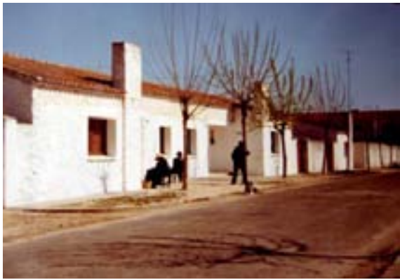
5.100. Viviendas de colonos en el nuevo pueblo de Barquilla de Pinares, Cáceres, A. Delgado de Robles y Velasco, 1957; Arch. Minist. Agricultura.
