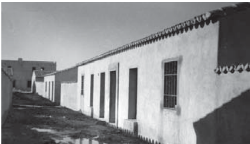
10.193. Viviendas en construcción en el nuevo pueblo de Entreríos, Badajoz, década de 1950; Arch. Minist. Agricultura.
