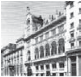
3.2. Palacio de la Equitativa, J. Grasés Riera, Madrid, 1882-1891 (San Antonio Gómez, C., 1996).
