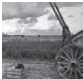
7.1. Paisaje transformado por el INC en la zona regable del río Alberche; Arch. Minist. Agricultura.
