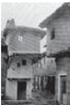
3.141. Casas populares en Villalón, Valladolid, Adolfo Blanco, Arquitectura, n.157, 1932.
