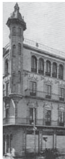
3.45. Casa en Sevilla, Aníbal González Álvarez, Arquitectura y Construcción , 1917.
