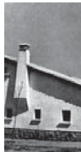
4.66. Casa el pueblo reconstruido de Villanueva del Pardillo, Madrid, Reconstrucción, n.130, 1956.
