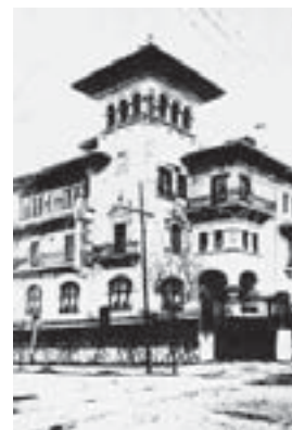
3.39. Casa para Luis Allende, Leonardo Rucabado, Bilbao, 1914; Basurto Ferrero, N, 1986 y La construcción moderna, n.15, 1915.
