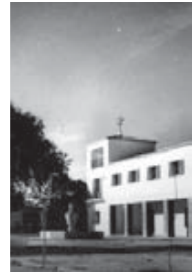
10.29. Valdeínigos (Cáceres, 1949), ayuntamiento integrado en el conjunto volumétrico de la plaza colocado en posición de esquina, con la torre como elemento de giro en el perímetro porticado de la plaza; Arch. Minist. Agricultura.
