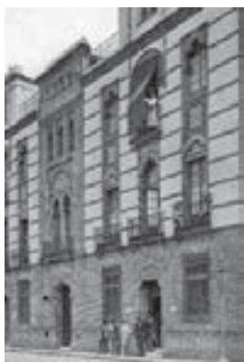
3.51. Casa en Sevilla, Aníbal González Álvarez, Arquitectura y Construcción, 1917.
