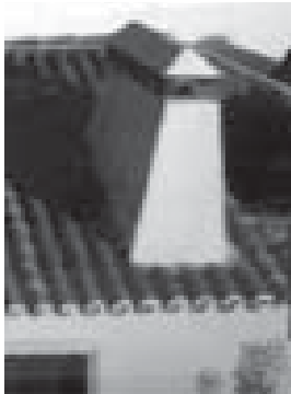
10.213. Detalle de chimenea en vivienda del nuevo pueblo de La Bazana, Badajoz, Alejandro de la Sota, 1954; Arch. Minist. Agricultura.
