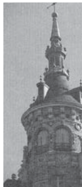
3.43. Detalle de la casa para Tomás Allende, último proyecto de Leonardo Rucabado, Madrid, 1916-1920 (Reig, M., 1985).
