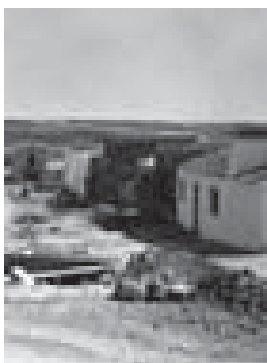
7.18. Viviendas en construcción de un nuevo pueblo del INC en Badajoz, área regable del pantano de Piedraguda; Arch. Minist. Agricultura.
