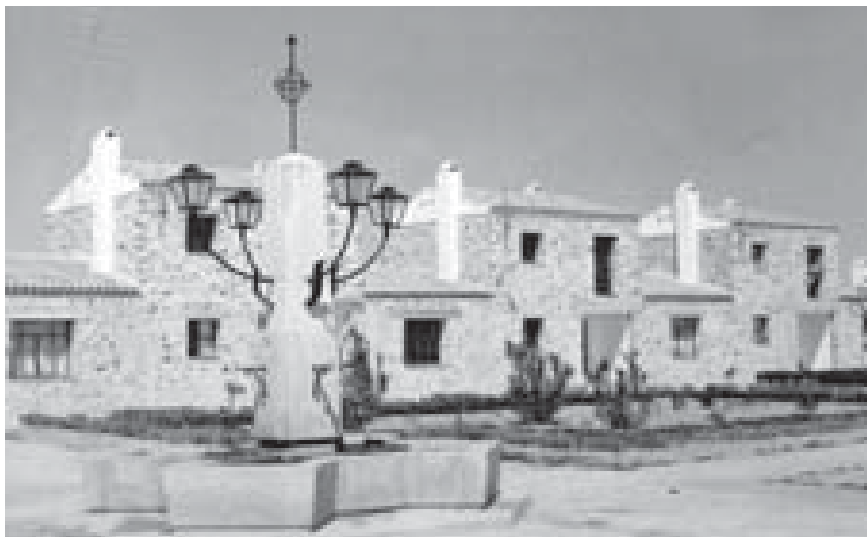
10.204. Viviendas del nuevo pueblo de Hernán Cortés (Badajoz, M. Rosado y M. Herrero, 1962), combinando en las fachadas la fábrica vista de piedra con los enfoscados lisos de mortero, que se pusieron 'de moda' a partir del éxito de Vegaviana; Arch. Minist. Agricultura.
