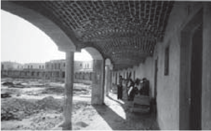
10.195. Viviendas de la plaza de Entrerriós en construcción, con empleo de la bóveda tabicada de ladrillo para la solución de la galería porticada hacia la plaza; A. de la Sota, década de 1950; Arch. Minist. Agricultura.
