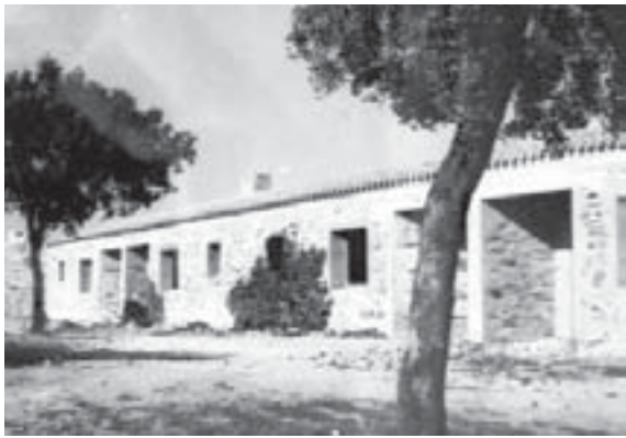
10.201. Viviendas del nuevo pueblo de Vegaviana en construcción, con los muros de mampostería de pizarra aún sin encalar; J.L. Fernández del Amo, 1954; Arch. Minist. Agricultura.
