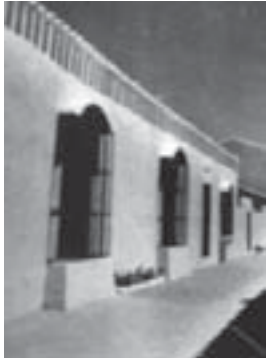
5.73. Ventanas de viviendas de colonos para el nuevo pueblo de Esquivel, Sevilla, A. de la Sota, 1952 (Sota Martínez, A. de la, 1989).
