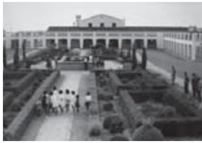
9.34. Balboa (1955); construcción de las esquinas de la plaza a través del recurso al pórtico perimetral. Esquema del autor de la tesis y fotografía del Arch. Minist. Agricultura.
