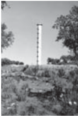
7.39. Torre de control y depósito de agua en la presa del embalse de Alcántara, Gijo de Galisteo y Granadilla; Arch. Minist. Agricultura.
