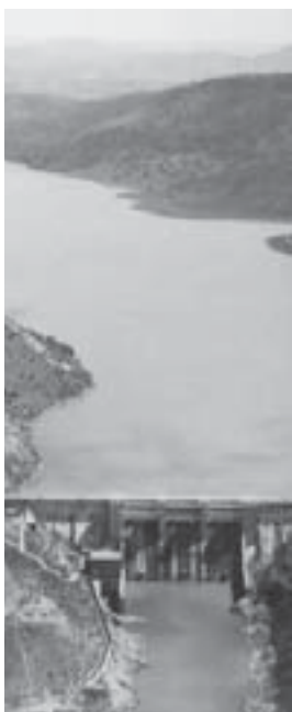
4.102. Vista parcial de la presa de Valuengo sobre el río Ardila. Álbum conmemorativo de los 25 años del INC en Extremadura, Arch. Minist. Agricultura.
