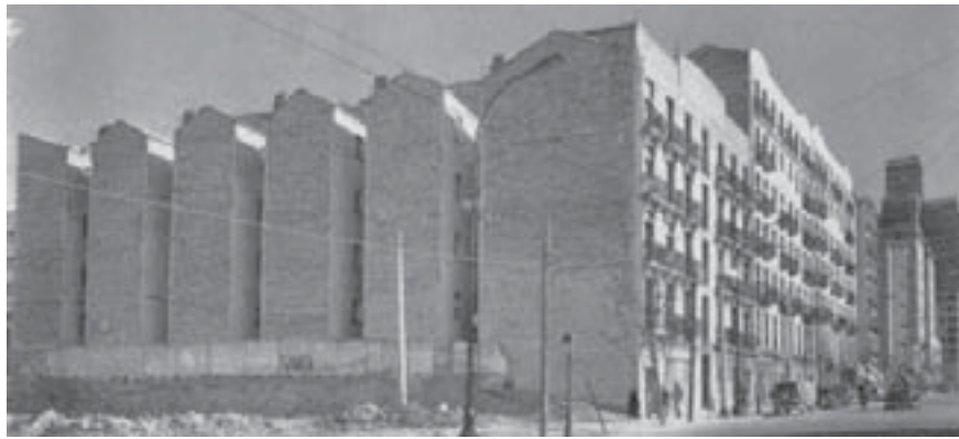
3.111. Bloque de viviendas en Madrid con medianera descubierta, 1929; en Arquitectura Española Contemporánea , C. Flores.
