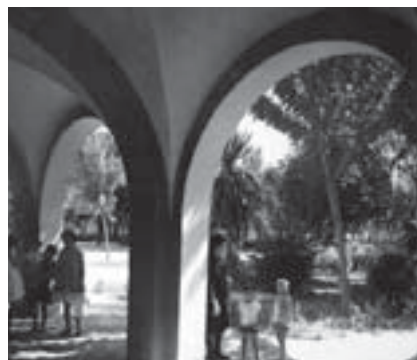
10.197. Bóvedas tabicadas de ladrillo encaladas en los nuevos pueblos de Guadiana del Caudillo y Valdelacalzada, Badajoz, 1950; Arch. Minist. Agricultura.
