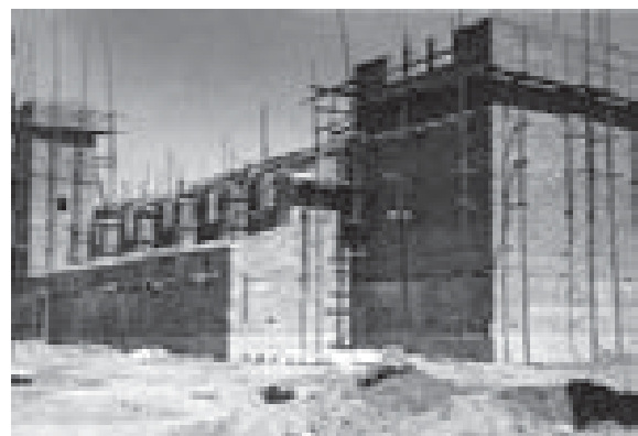
10.75. Iglesia de Valdelacalzada (Badajoz, 1956) en construcción: interior de la nave con los arcos fajones en construcción y exterior con la construcción de la capilla del presbiterio; Arch. Minist. Agricultura.
