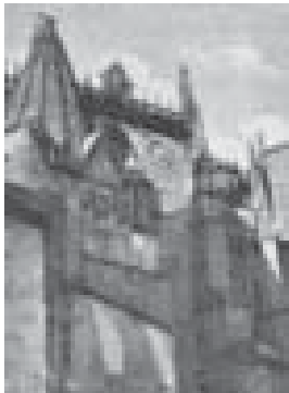
2.14. Puente romano de Alcántara, y catedral de Plasencia, viaje de alumnos de la Escuela de Arquitectura a Extremadura, 1934, Boletín de la Sociedad Española de Excursiones, n.42, 1934.
