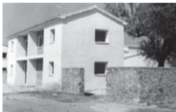
5.65. Tapias de piedra y encalados lisos de mortero de cal en el nuevo pueblo de Tiétar del Caudillo, Cáceres, P. Pintado Riba, 1957, Arch. Minist. Agricultura.
