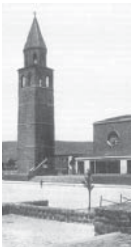
7.75. Campanario de la iglesia de Carbonia, 1937-1938 (Pennacchi, A., 2003).
