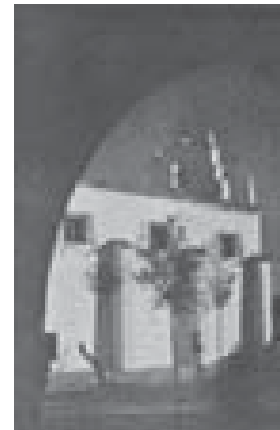
4.129. Iglesia en el nuevo pueblo de El Torno, Cádiz, V. D'Ors y J. Subirana, 1943, Revista Nacional de Arquitectura , n.83, 1948.
