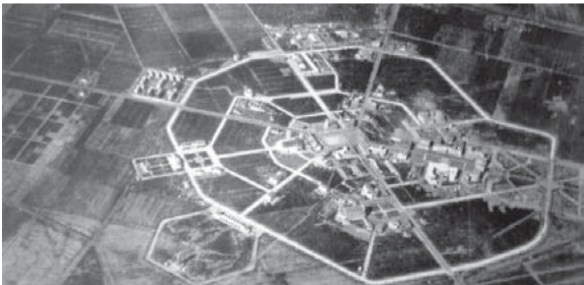
8.74. Foto aérea de la gran ciudad del Agro Pontino, primera de las que luego vendrán, Littoria-Latina, O. Frezzotti, 1932 (Muratore, G., Ciucci, G., 2004).
