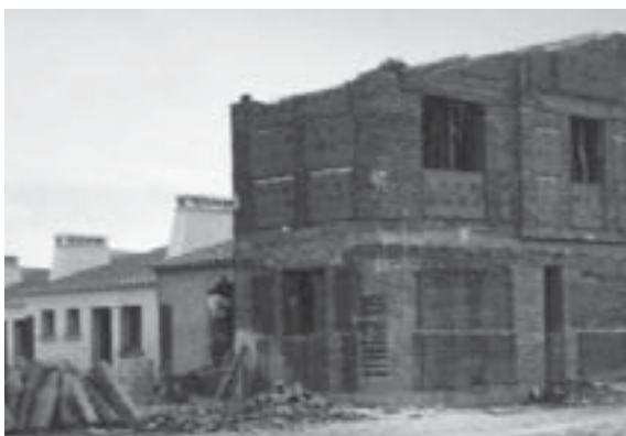
10.192. Viviendas en construcción en los nuevos pueblos del INC de Gévora del Caudillo y Sagrajas, Badajoz, década de 1950; Arch. Minist. Agricultura.
