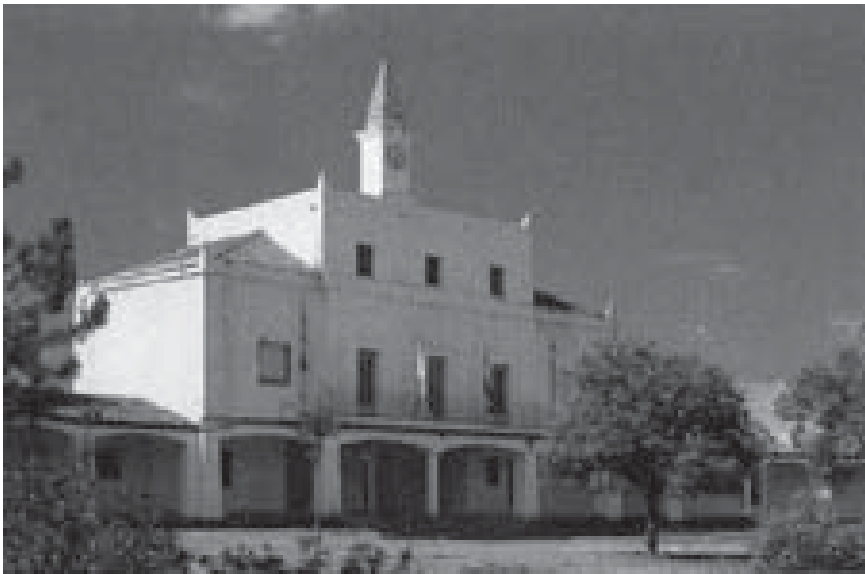
10.51. Ayuntamiento de Entreríos (Badajoz, 1955), composición tripartita con simetría volumétrica y de organización del plano de fachada (Baledellou Santolaria, MA., 2006).
