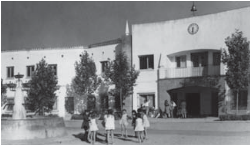
10.13. Elementos invariantes en el ayuntamiento: pórtico, balcón, reloj y pieza vertical. Edificio para la Administración en el nuevo pueblo de Gévorá del Caudillo (Badajoz, 1954); Arch. Minist. Agricultura.
