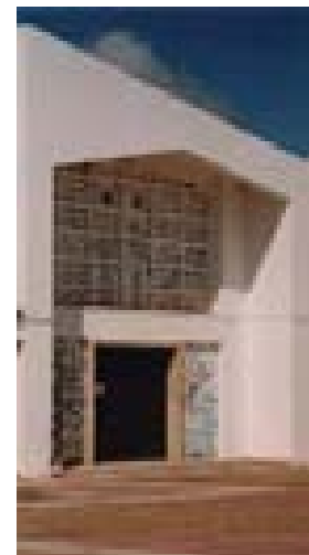
5.104. Iglesia en el nuevo pueblo de Valdesalor, Cáceres, M. Jiménez Varea, 1959; del autor de la tesis.
