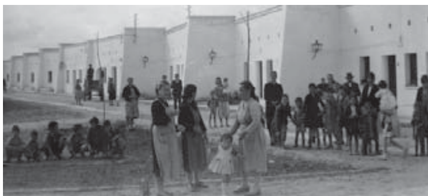
9.160. Perfil quebrado de la calle corredor como primer intento de crear un espacio amplio que acompaña al desarrollo de la calle para la relación vecinal; Gévora del Caudillo (Badajoz, 1954); Arch. Minist. Agricultura.
