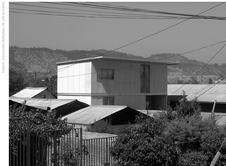
Figura N° 3: Vivienda 9x18 construida
