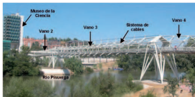
Fig. 3: Vista general de la PMC de Valladolid
