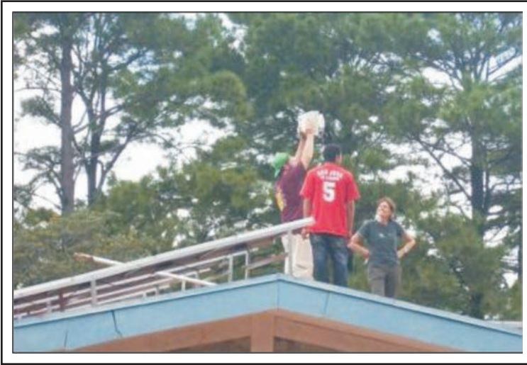
Gráfico 9. Instalación y capacitación sobre WiMAX-WiFi.
