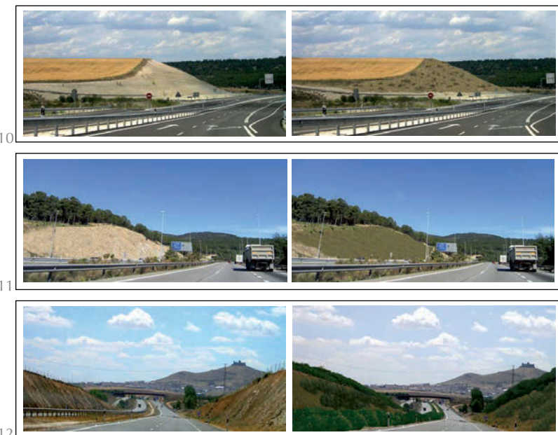
12. Escenario taludes: tratamientos en tramo en trinchera (fotos S315 y S417).
