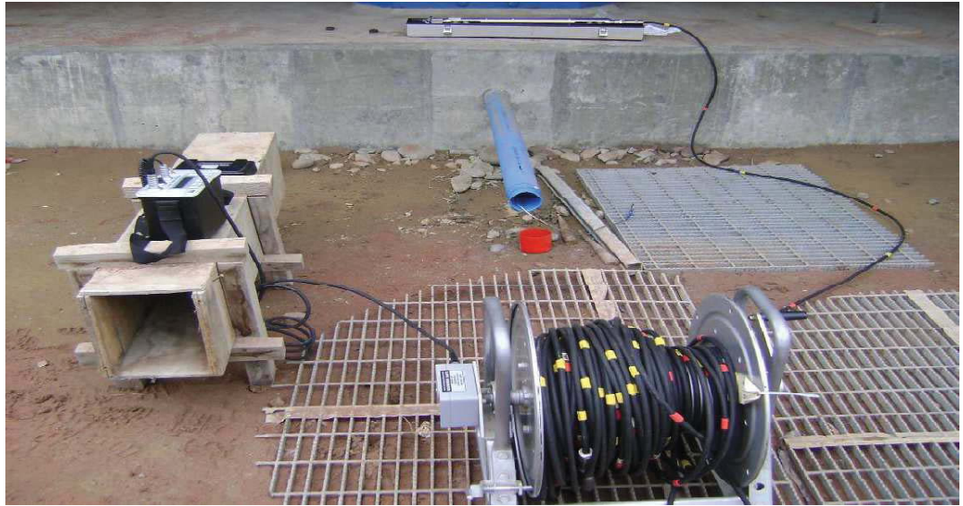
Ensayo de comprobación del asentamiento de un Tanque de GNL
