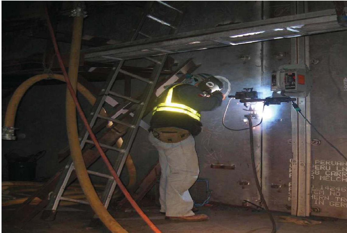
Soldadura de la chapa de acero al 9 % Ni
