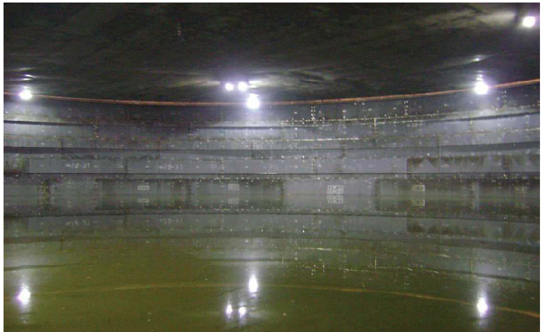
Tanque de GNL durante su prueba hidráulica
