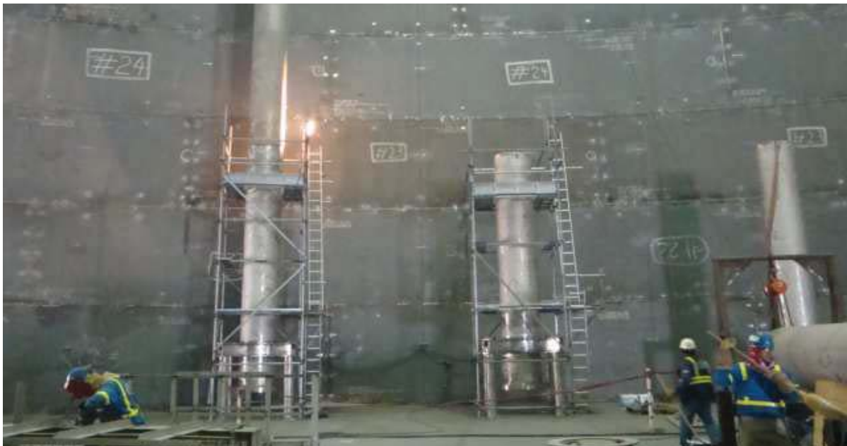
Montaje de los pozos de bombas
