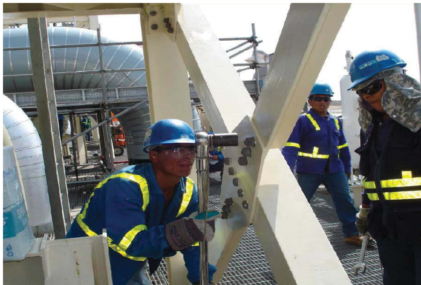
Apriete de pernos en el acero estructural
