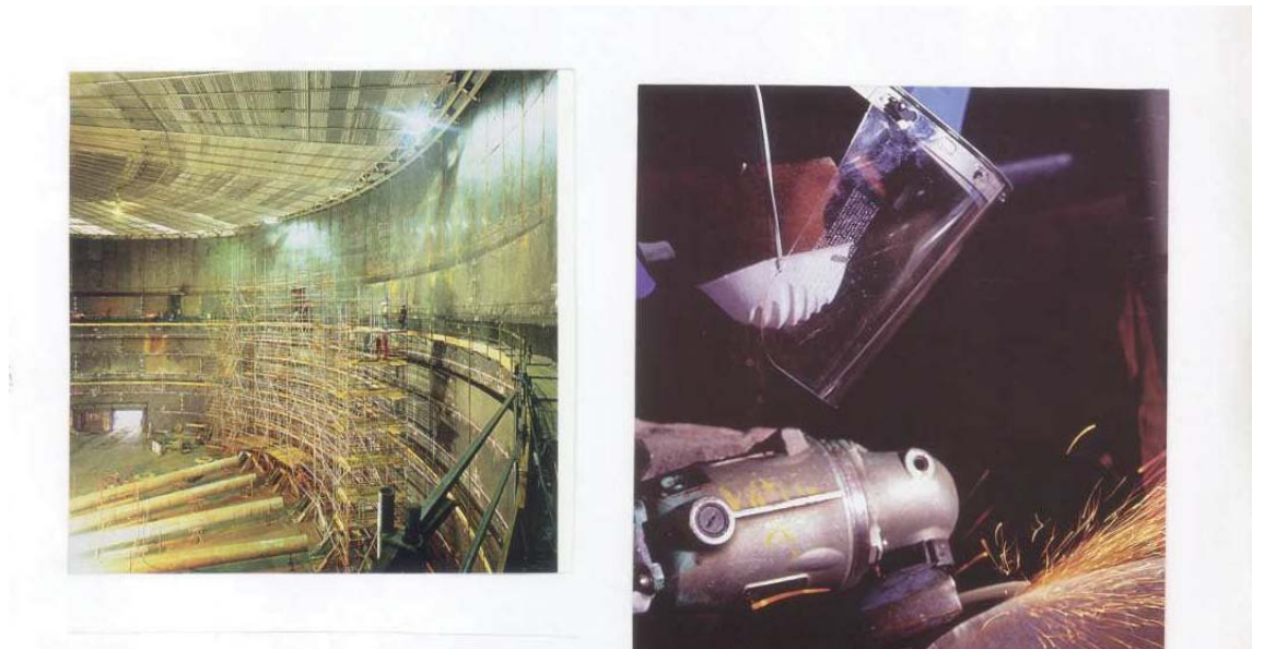
Precauciones de seguridad durante la construcción de un Tanque
