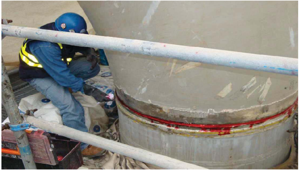
Ensayo no destructivo por líquidos penetrantes
