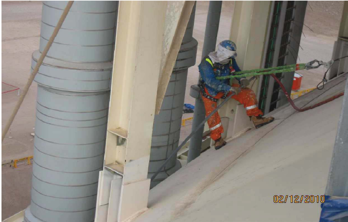
Retoques finales en el domo de un Tanque de GNL
