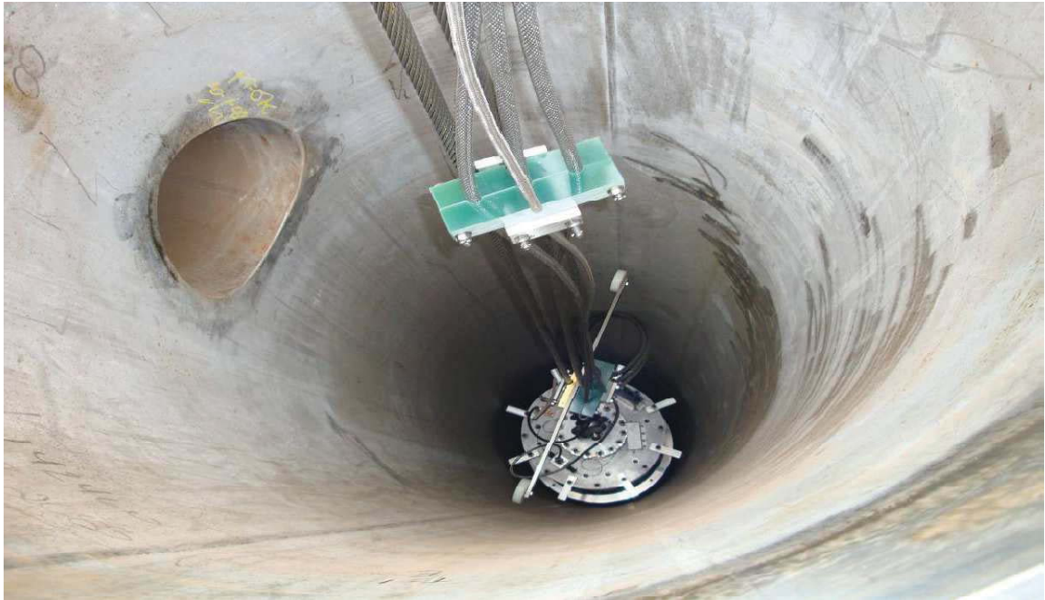
Bomba de GNL durante su instalación en el pozo
