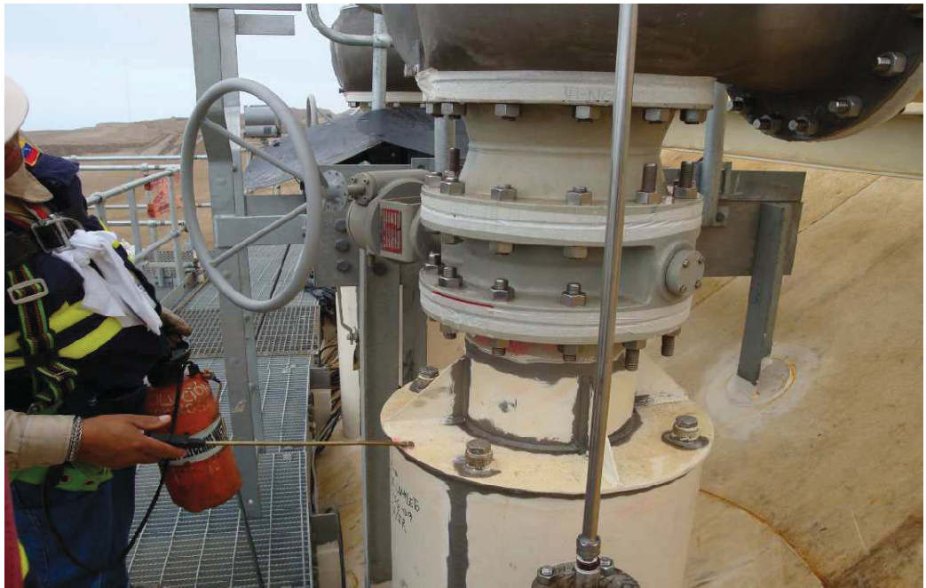
Comprobando posibles fugas durante el ensayo de estanquidad
