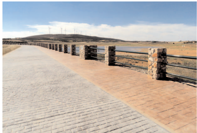
Fig. 5. Coronación de la presa vista desde el estribo izquierdo.
