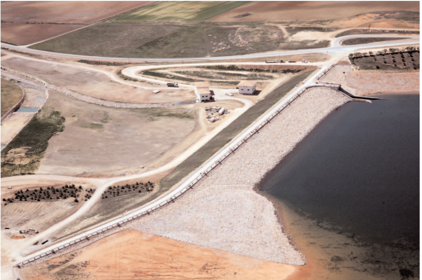
Fig. 10. Vista aérea de la presa.
