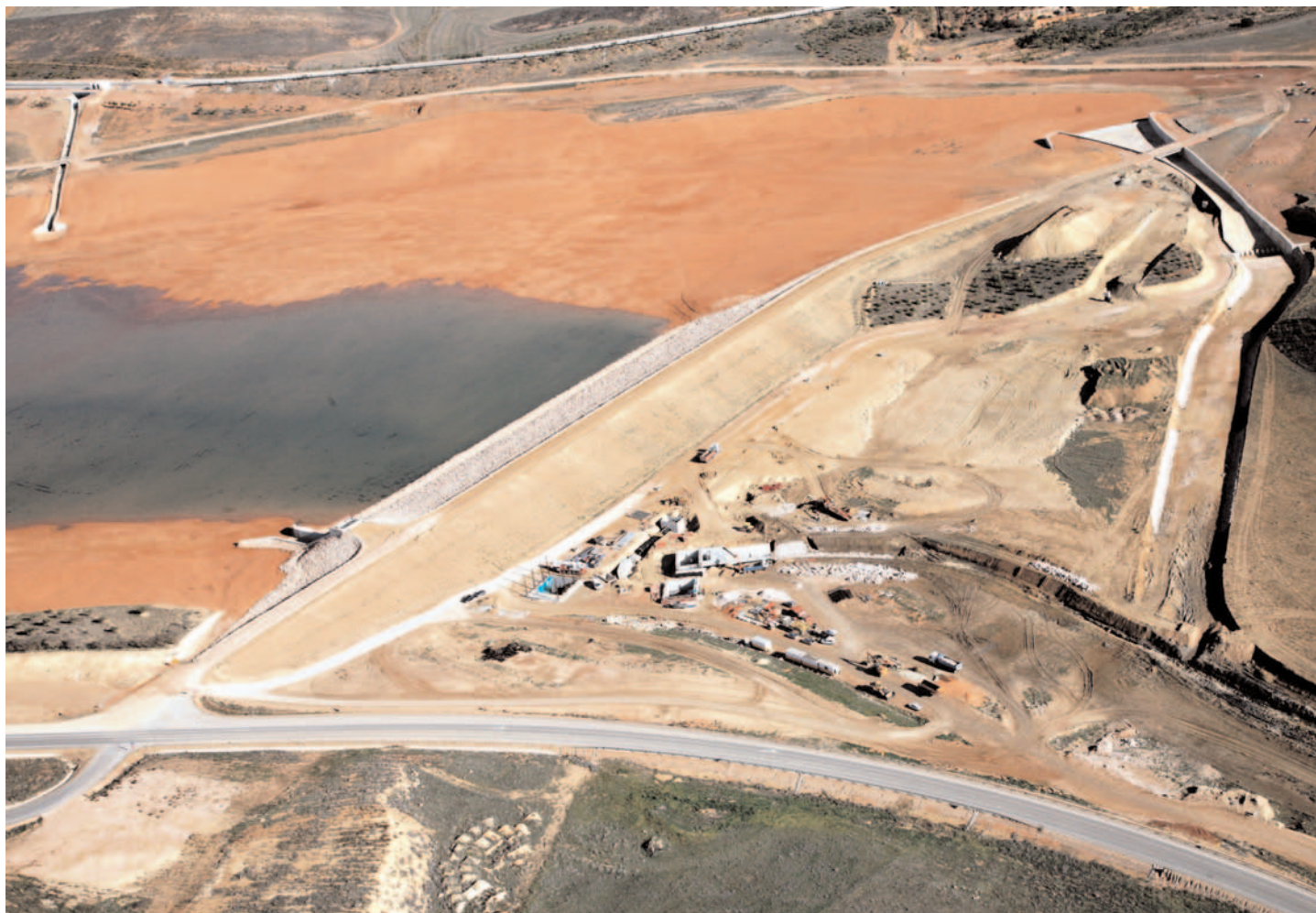
Fig. 2. Vista aérea de la presa durante la construcción de las obras.
