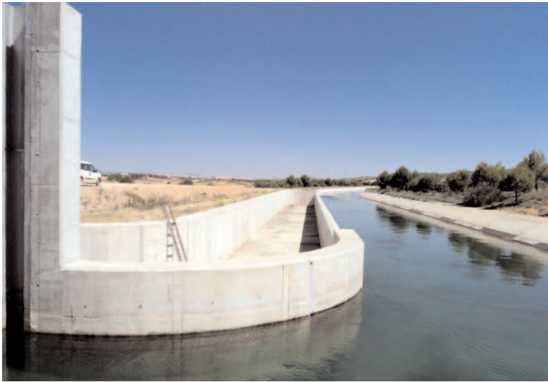
Fig. 9. Aliviadero lateral de la toma del Acueducto Tajo-Segura.
