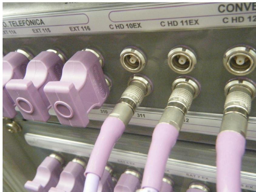
Fig. 144 Conectores FFA.0A. Por cortesía de RTVE.
