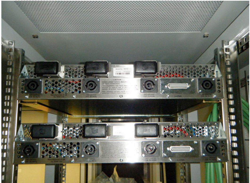
Fig. 41. Trasera de las fuentes de alimentación redundantes de la matriz Sirius 850. Por cortesía de RTVE.
