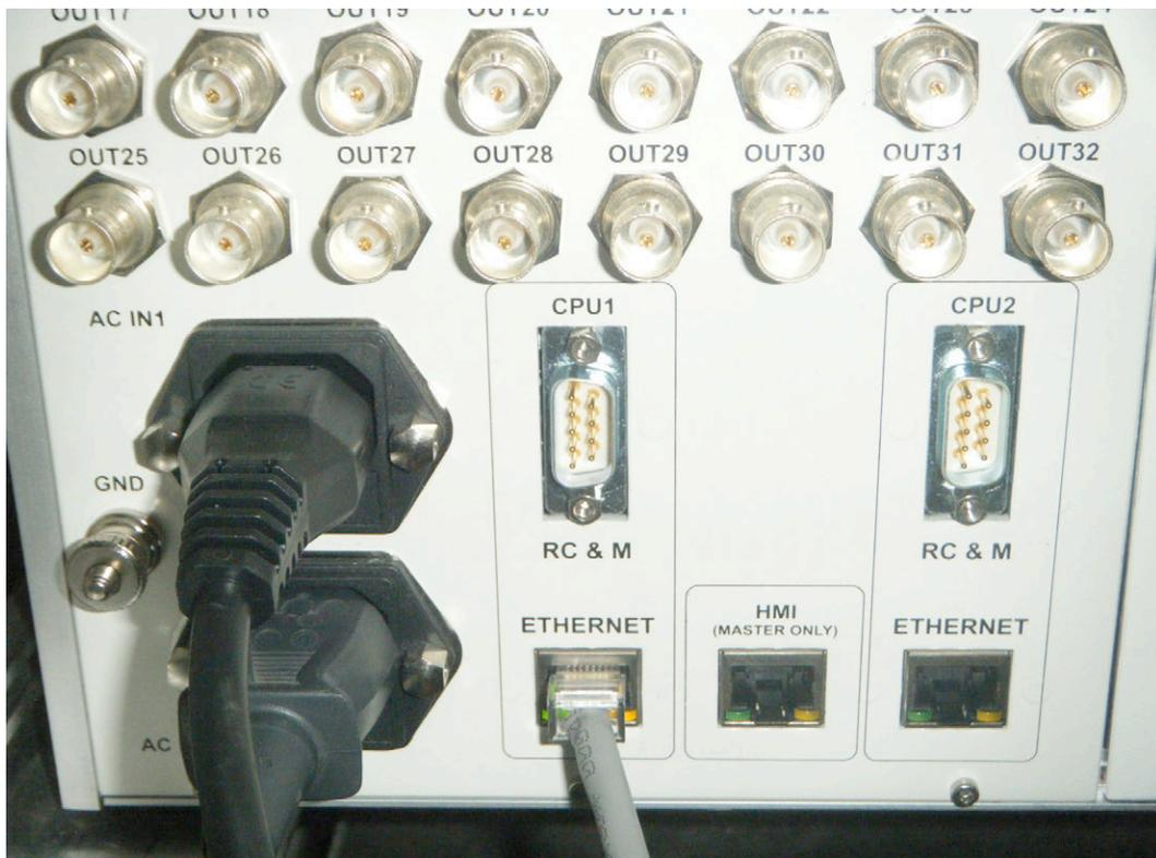
Fig. 161 Conexionado de alimentación y control de la matriz Nigma. Por cortesía de RTVE.
