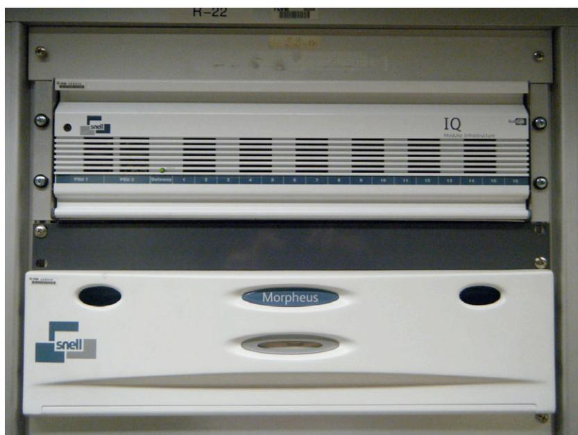
Fig. 47. Controladora Morpheus. Por cortesía de RTVE.
