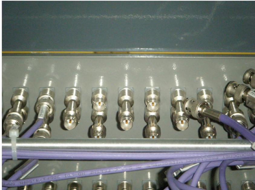
Fig. 141 Parte trasera de un panel Lemo. Por cortesía de RTVE.
