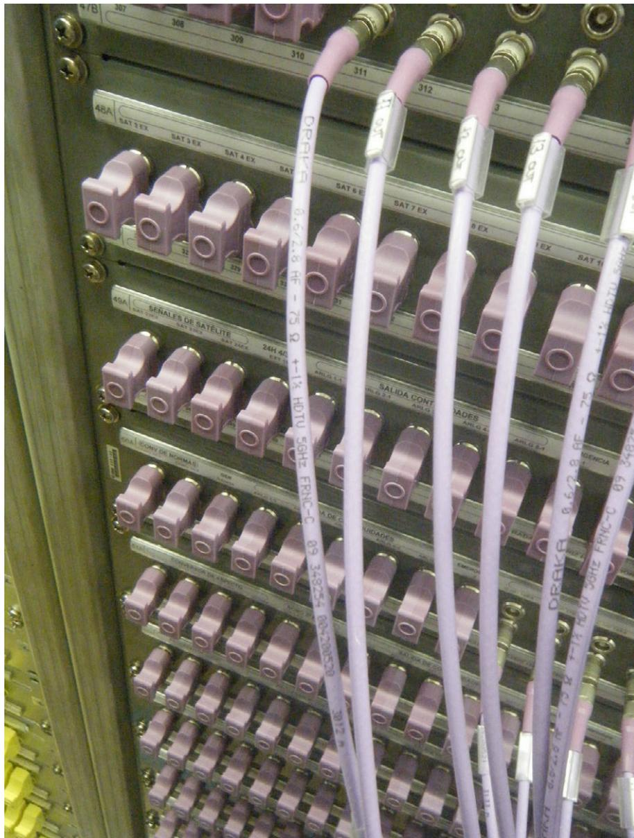
Fig. 145 Instalación de los paneles de HD en RTVE. Por cortesía de RTVE.
