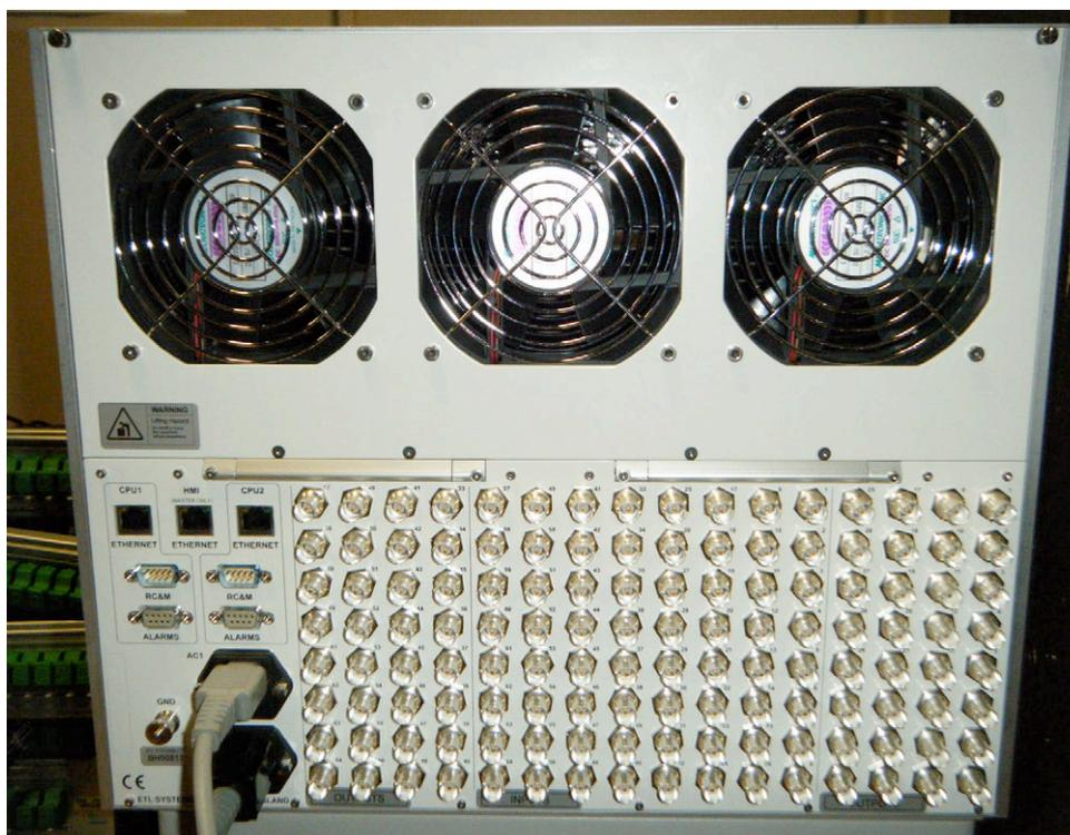
Fig. 180 Trasera de la matriz ETL Vortex. Por cortesía de RTVE
