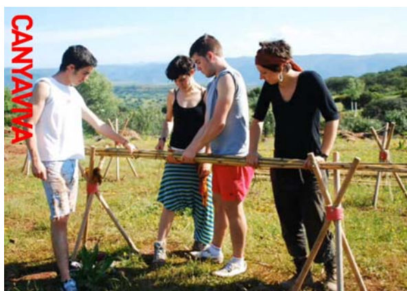
Imagen 13: Canyaviva. Construcción de estructuras con caña
