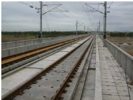
Vía en placa – losas prefabricadas
