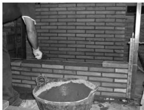
Figura 2. Fabricación de un muro.
