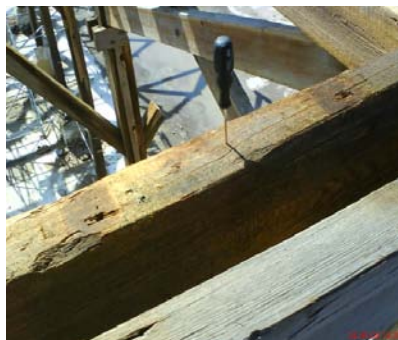
Fig.3.- Inspección visual con ayuda de punzón
