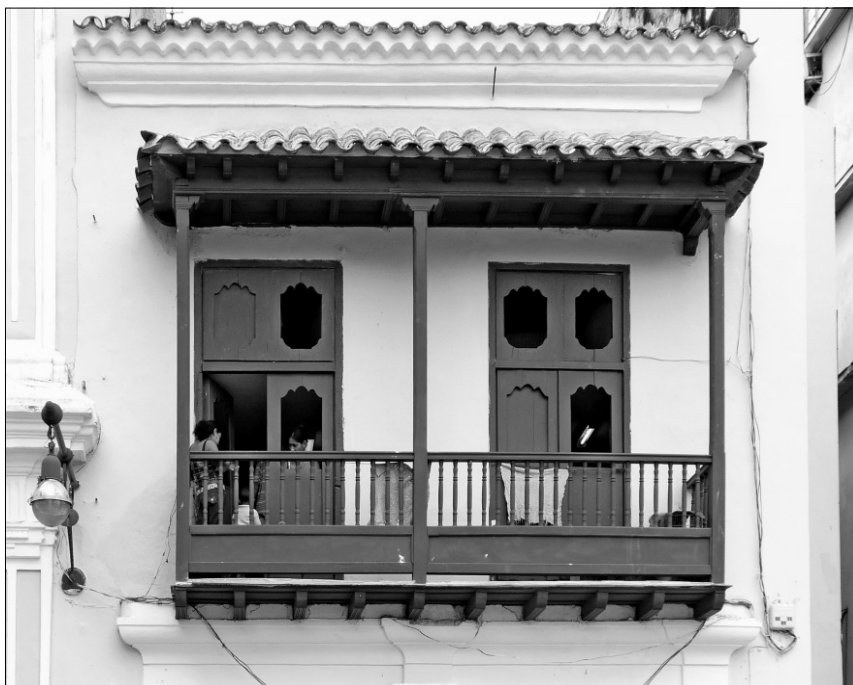
FIGURA 6: Balcón con tapafaldas en la calle Oficios esquina a la Plaza San Francisco en La Habana.
