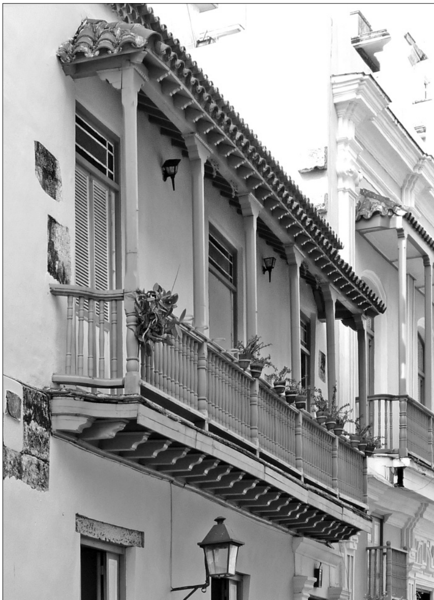
FIGURA 8: Balcones en la calle Oficios con antepechos laterales de directriz mixtilínea.
