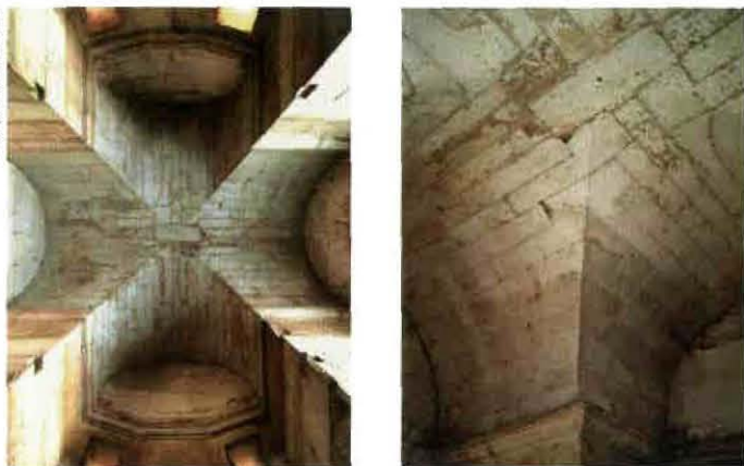
Fig. 7 / Bóvedas de arista en la planta baja de la tumba de Teodorico en Rávena
