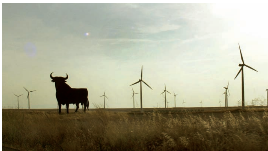
Figura 1. Los aerogeneradores son infraestructuras imponentes, con aspas en movimiento, y que además, por requerimientos técnicos, casi siempre han de ubicarse en espacios abiertos o en posición dominante sobre el entorno. (Foto: Aerogeneradores en Zaragoza. España. Autor: AGV).
