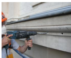
6.2: Ejecución de taladros
