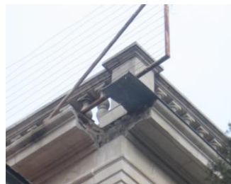
Figura 2: Moldura desprendida
