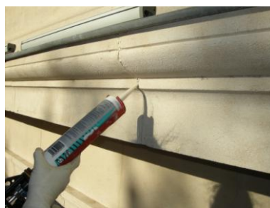
7.2: Sellado de junta de dilatación
