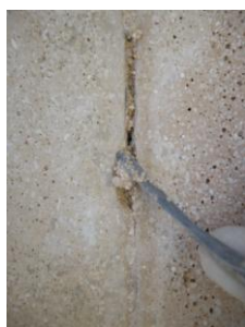
7.1: Saneado de junta abierta
