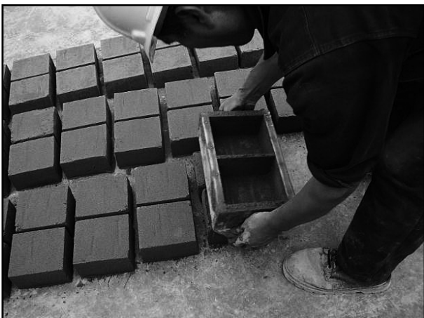
Figura 6. Preparación de las piezas de adobe. Figure 6. Preparation of the adobe pieces.
