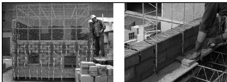
Figura 9. Construcción de los prototipos, a la izquierda de adobe y a la derecha de ladrillo hueco. Figure 9. Construction of the prototypes, adobe to the left and hollow brick to the right.
