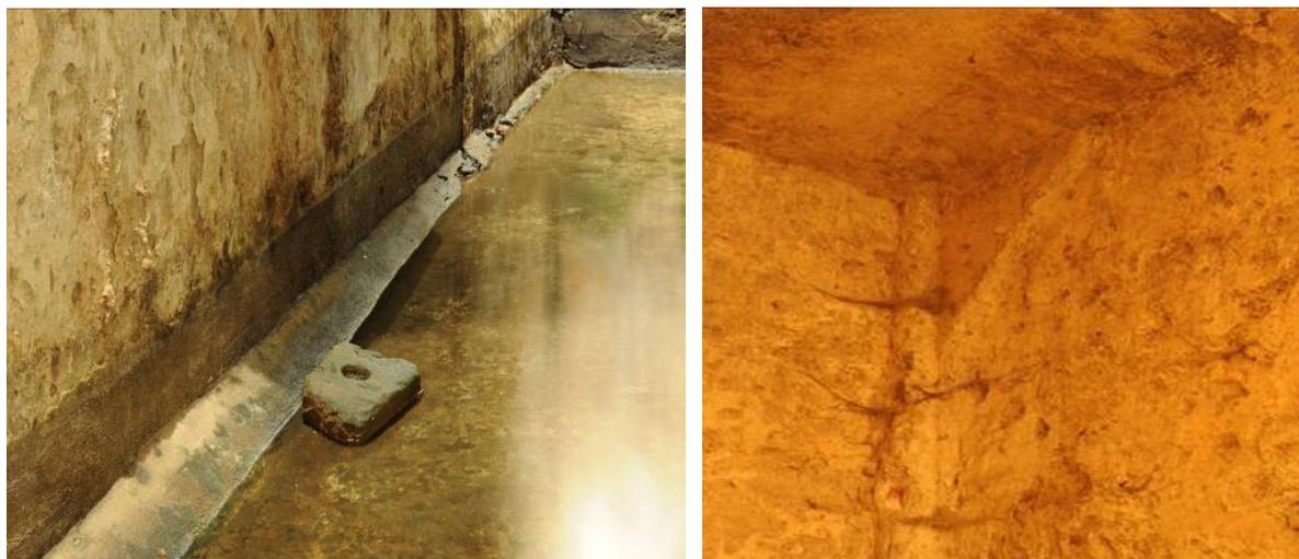
**Fig. 2. Escocia en el perímetro del pavimento. Fig. 3. Bocel (esquina O debajo de meseta de escalera)**
